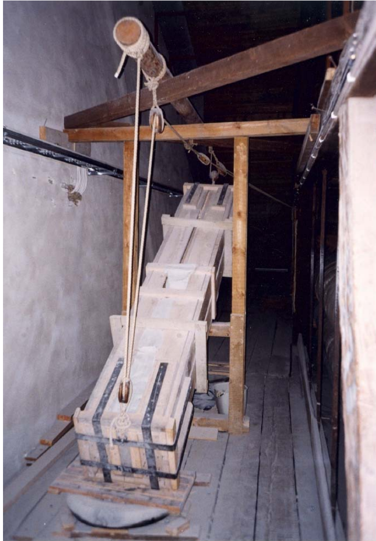
Fig. 9, dispositivo del tuono, Drottningholms Slottsteater, XVIII sec.
