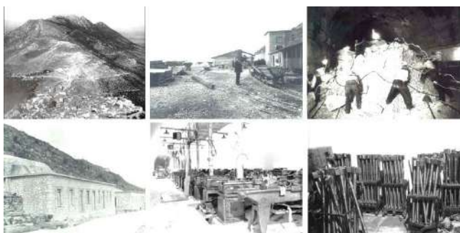
Fig.2 Il monte Soratte prima della realizzazione delle gallerie (foto aerea da archivio privato); il cantiere di costruzione delle gallerie e delle caserme (da archivio Ditta G. Perucchetti); le gallerie usate come fabbrica della Breda (da Bundesarchiv)
