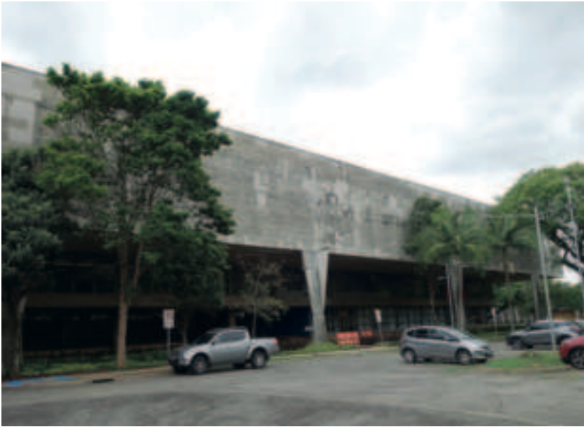
Fig. 2. São Paulo, Brasil, Edifício Vilanova Artigas, fachada sul depois das obras / San Paolo, Brasile, Edifício Vilanova Artigas, la facciata sud dopo l'intervento (© Beatriz Mugarz Kühl, 2021)
