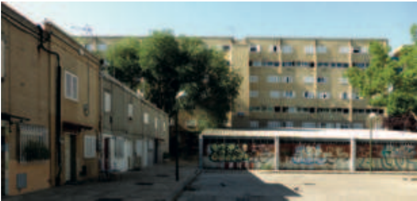
Fig. 6. Edificación residencial y complementaria (2020) / Residential and complementary building (2020) (© Noelia Cervero Sánchez)
