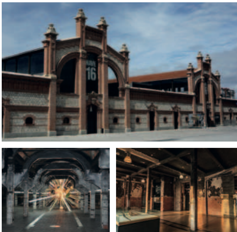
Figg. 7, 8, 9. Matadero Municipal (Madrid), vista exterior de la Nave 16 e interior de la nave frigorífica instalada en la Nave 17 ( Intermediae , arquitectos Arturo Franco y Fabrice van Teeslar, 2006), donde se desarrolla el proyecto “ Abierto por Obras ”, con la obra “ Agujero Negro Cignus ”, del artista Björn Dahlen (2015), arquitectos / Municipal Slaughterhouse (Madrid), exterior view of Building 16 and interior of the cold storage building installed in Building 17 ( Intermediae , architects Arturo Franco and Fabrice van Teeslar, 2006), where the project “ Abierto por Obras ” takes place with the work “ Agujero Negro Cignus ” by the artist Björn Dahlen (2015), architects (© Carlos Colás, 2022)
