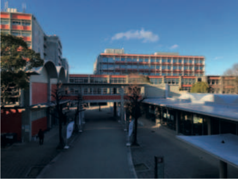
Fig. 5. View of the “Main Street” after the renovation, January, 2022 / Vista della “Main Street” dopo l’intervento di riqualificazione, gennaio 2022 (Pietro Vecchi, Ken-ichi Suzuki)
