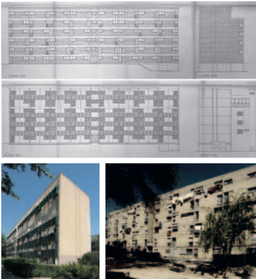
Fig. 3. Bloque lineal, estados inicial y rehabilitado (1994, 2020) / Linear block, initial and rehabilitated state (1994, 2020) (©Archivo CREA Arquitectos y Noelia Cervero Sánchez)
