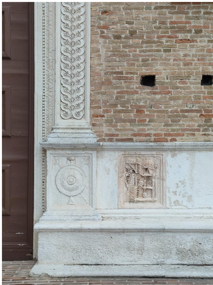
Fig. 16 Urbino, palazzo Ducale, dettaglio della panca basamentale e del suo aggancio con gli elementi architettonici del portale (foto dell'autrice)
