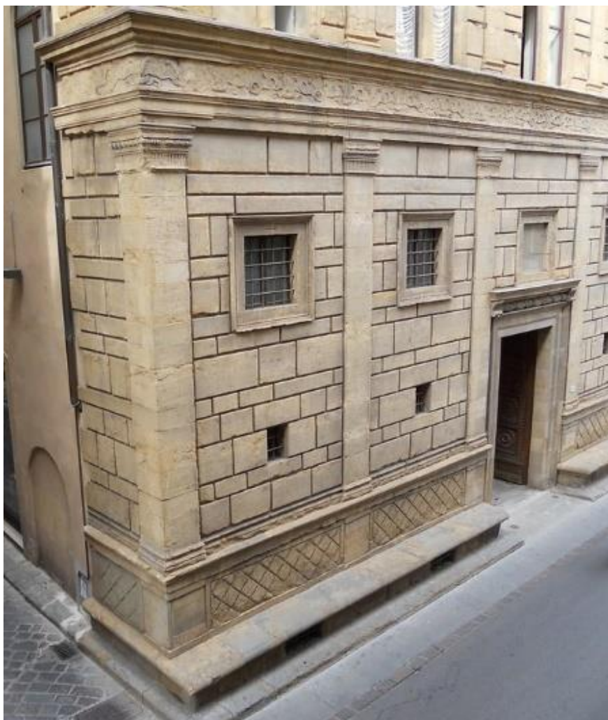
Fig. 10 Firenze, palazzo Rucellai, dettaglio del piano terra con la panca basamentale in facciata
