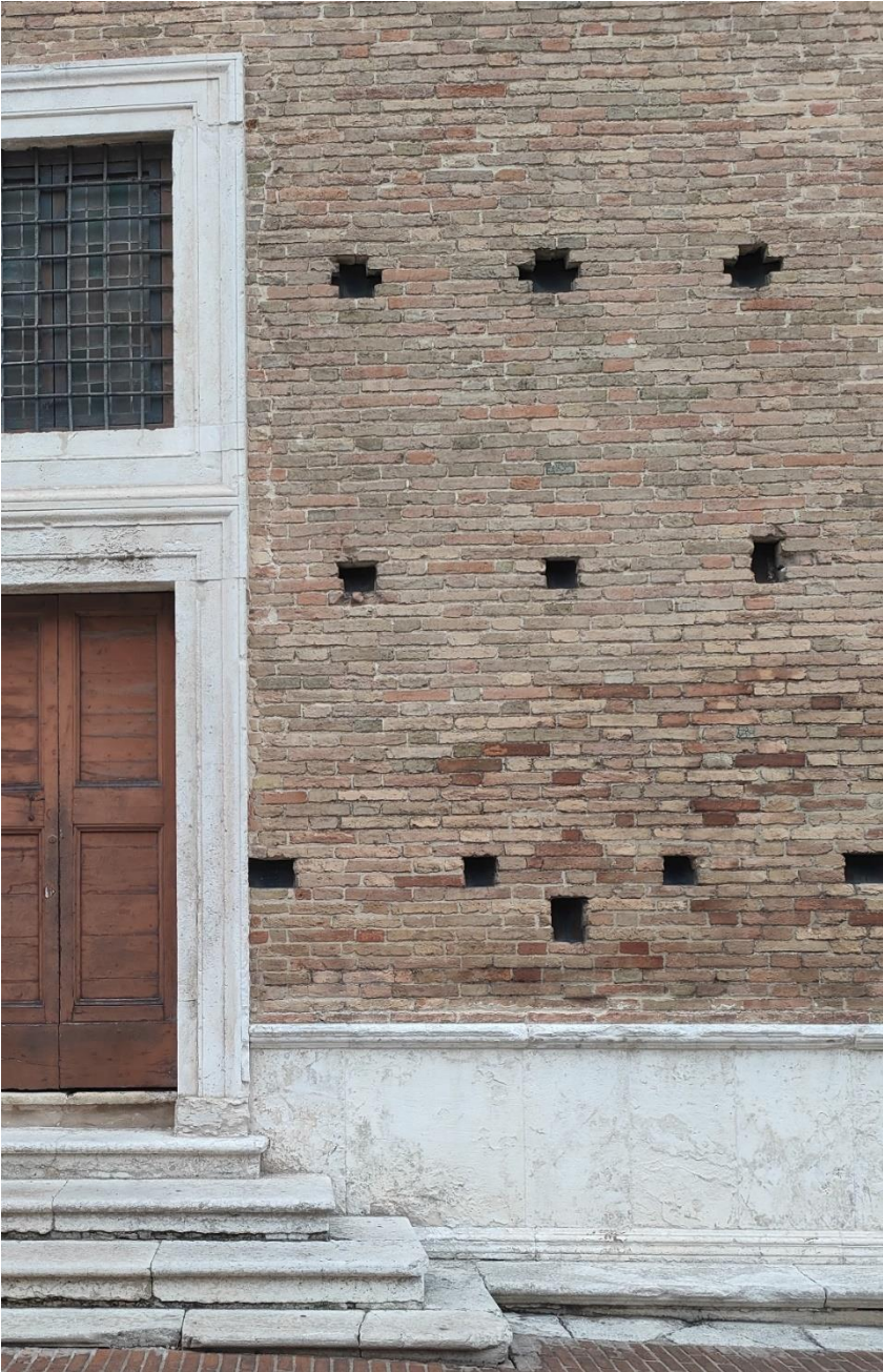
Fig. 13 Urbino, palazzo Ducale, dettaglio dell'aggancio della panca basamentale ai gradini della porta sul lato orientale della fabbrica (foto dell'autrice)
