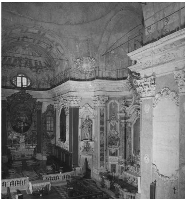
Fig. 4 - Genova, chiesa della Missione, interno. Si noti la volta a vela, impostata su quattro pilastri sporgenti dai lati diagonali dei piloni (da N. Pazzini Paglieri, R. Paglieri, v. nota 6, fig. 146, p. 118).
