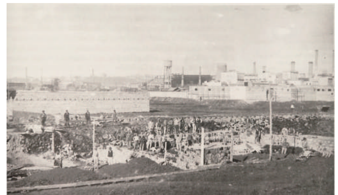
2.18/ La rampe d'accesso ai cavalcavia della Garbatella in costruzione, 17 gennaio 1921.
