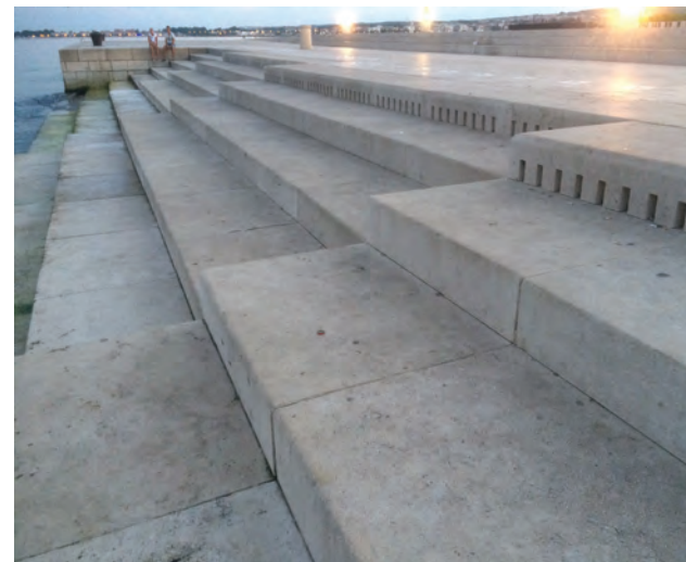
Fig. 1. Sea Organ , Zadar. Vedere a treptelor cu seria de goluri de aer care permit transformarea în sunete muzicale a aerului împins de valuri. / Zadar Sea Organ . View of the steps with the series of air holes that let the Sea Organ transform the air pushed by the waves into musical sounds Sursa/ Source: Alessandra Capanna, 2016
