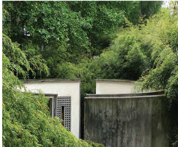
Fig. 3. Paris, Cylindre Sonore . Cylindre Sonore este o cameră cu pereți dubli din beton situată la un nivel inferior față de drumurile din apropiere, ca o cavitate de carieră care dispare în pădurea de bambus a parcului./Paris, Cylindre Sonore . The Cylindre Sonore is a concrete double-wall room located on a lower level with respect to the nearby paths, as a quarried cavity that disappears into the bamboo forest of the park.
