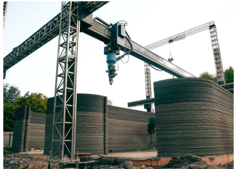
Immagini di cantiere. Fonte: Team4UA
