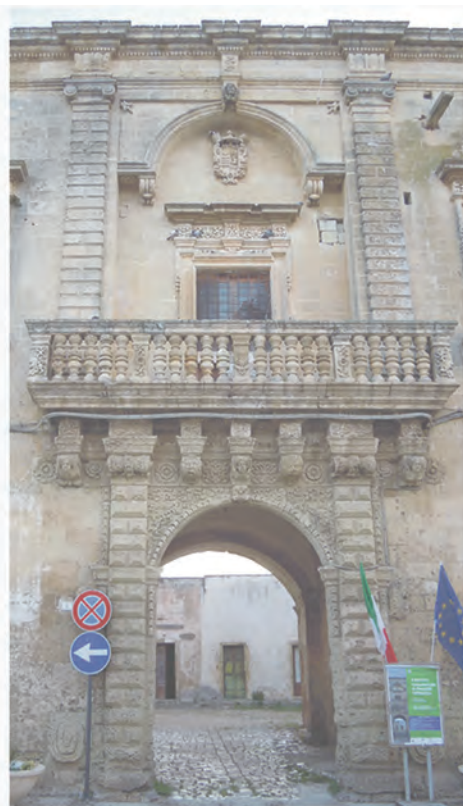
PALAZZO VERNAZZA (CASTRI DI LECCE) Serrato da paraste bugnate, il portale è sovrastato da un balcone su mensole
