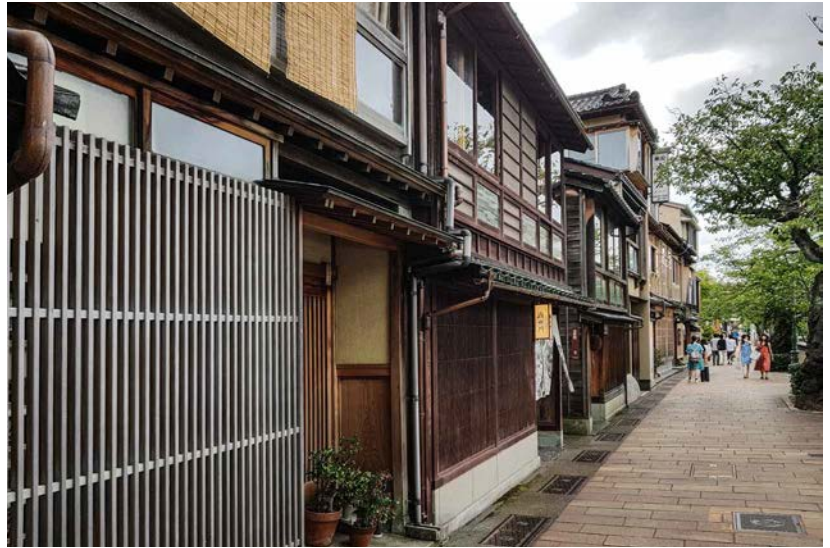
In alto e in basso: vie del tessuto storico di Kyoto dove si possono osservare le facciate delle machiya caratterizzate dalle tende di ingresso noren e dai pannelli in listelli di legno renji che hanno la funzione di spazio intermedio di collegamento con l'esterno. Foto dell'autore.
