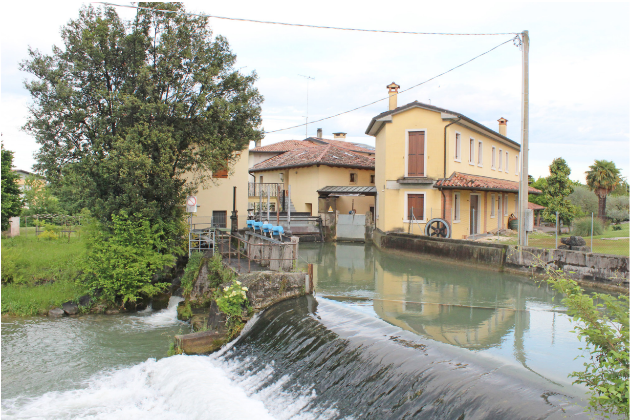
Figura 2. Recupero di una storica opera di presa idraulica lungo il fiume Meschio. Il salto che una volta azionava ruote idrauliche produce oggi energia elettrica. L'intervento riduce il consumo di suolo e diminuisce l'impatto sul fiume già artificializzato, valorizzando l'energia grigia impiegata nella costruzione delle precedenti opere idrauliche. Fonte: fotografia dell'autore, 2021.
