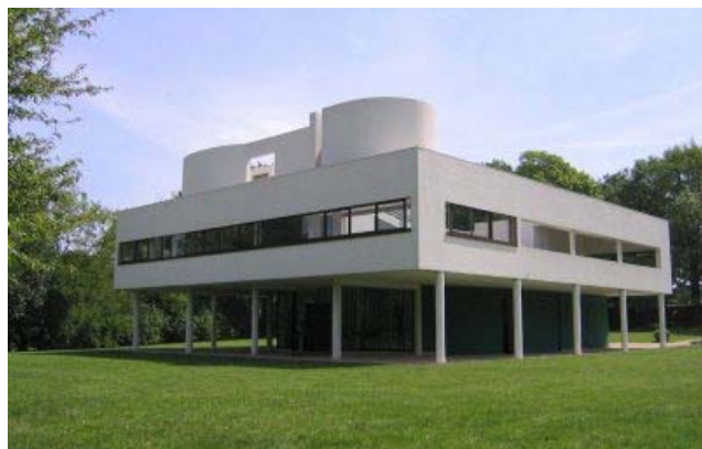
Poissy (Francia), Villa Savoye (Le Corbusier, 1929-31). Lo stato attuale dopo numerosi interventi di ripristino e manutenzione.
