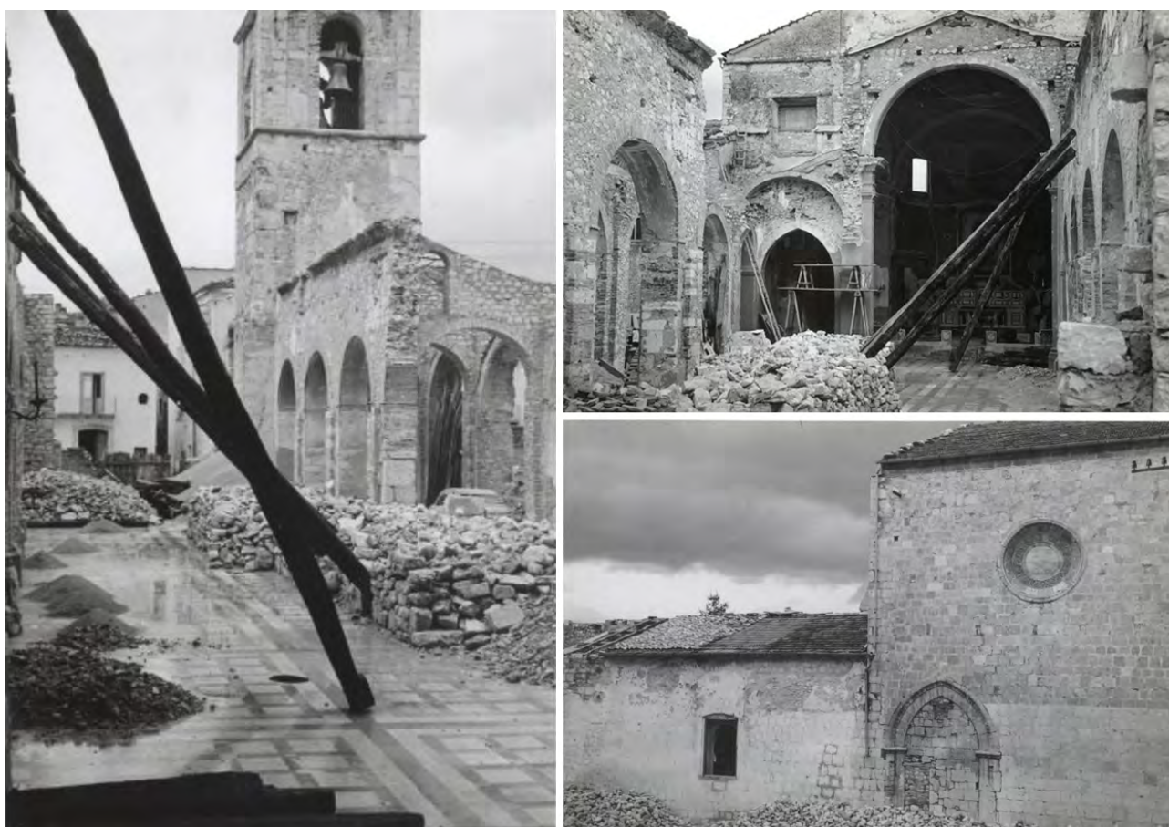
1: Bojano, Cattedrale di Bojano (CB), 1943-1946, immagini dei danneggiamenti subiti alla struttura (foto di J.B. Ward-Perkins) 3 .
