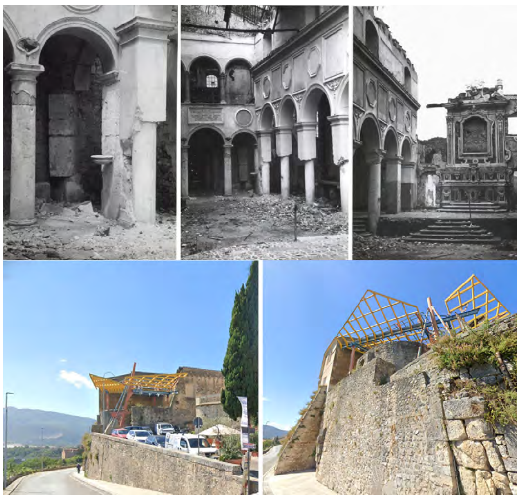
6: A), B), C) Isernia, 1943-46, monastero di S. Maria delle Monache (J.B. Ward-Perkins) 13 . D), E) Attuale sistemazione del monastero, la cui reintegrazione è realizzata mediante interventi nei quali il rapporto antico-nuovo è estremizzato, perdendo finanche l'immagine volumetrica della preesistenza (foto di M. Vitiello, 2023).
