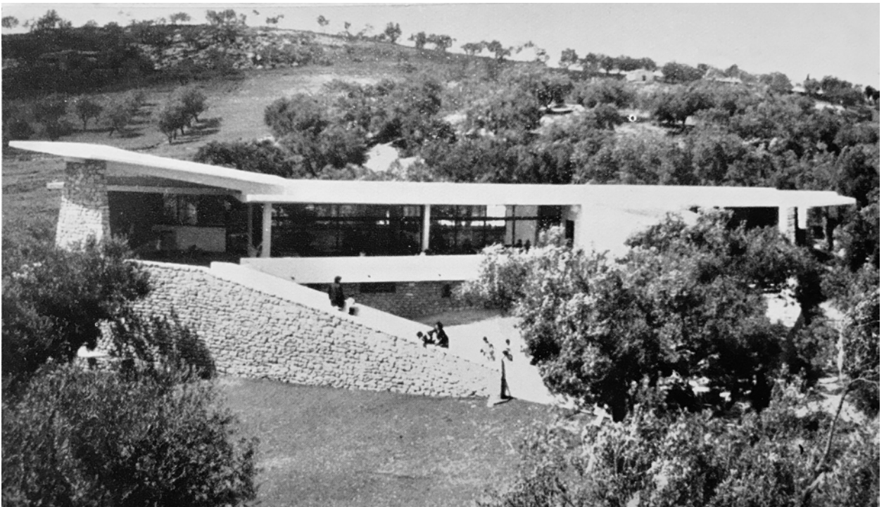
118. Villaggio Monte degli Ulivi, Riesi, 1968: l'asilo appena realizzato (da VINAY, Giorni a Riesi, cit., s.p.).
