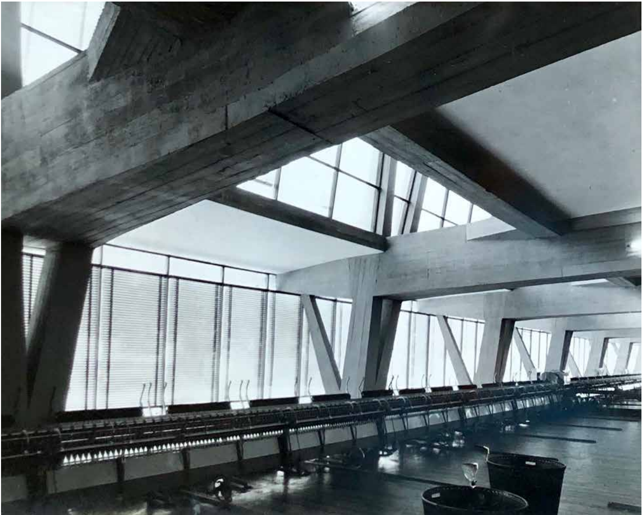
158. Fabbrica per filature Goti, Campi Bisenzio, 1959-1962: fotografia dell'interno del salone centrale con la sequenza di pilastri ramificati in tre bracci (Archivio CSAC, Parma, fondo Leonardo Ricci).
