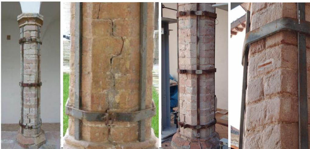
Fig. 255 - Convento di San Girolamo, Spello (PG). Colonne in laterizio con evidenze di schiacciamento (A. Borri 2013)
