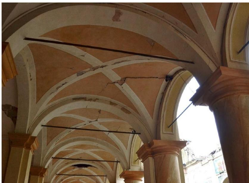
Fig. 73 - San Paolo a Concordia sulla Secchia (MO), fessurazione delle volte della navata laterale (A. Giannantoni 2013)
