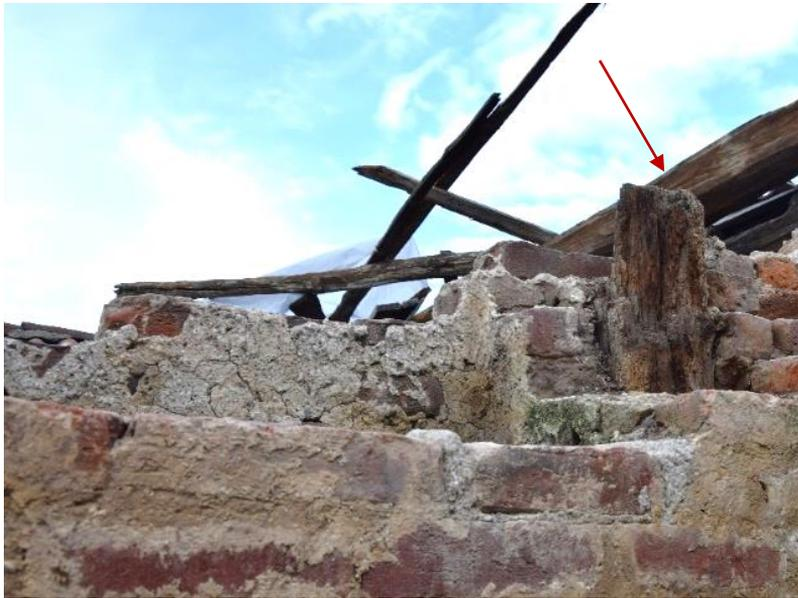
Fig. 52 – Castello Visconteo di Cusago (MI): con la freccia in rosso si indica un elemento ligneo verticale di rinforzo posizionato a lato di un condotto (A. Giannantoni 2020)
