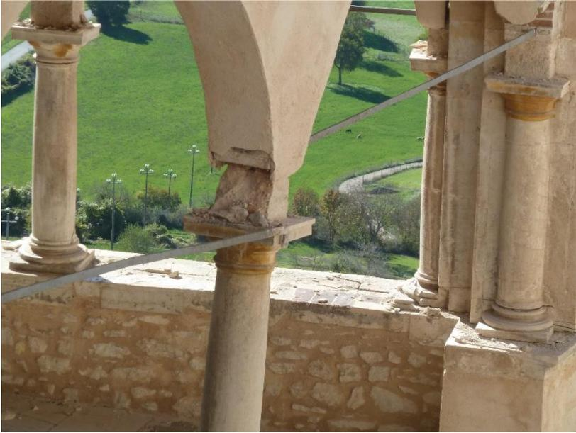
Fig. 84 - Cerniera plastica al livello dell'imposta dell'arco del portico (A. Giannantoni 28/10/2016)
