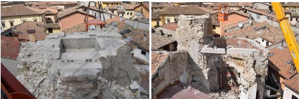
Fig. 241 - Chiesa Dell'Addolorata, Norcia (PG) a sinistra base della cella campanaria con all'interno le pareti in cemento armato, a destra vista della zona Presbiteriale e del Campanile. (A. Giannantoni 2018)
