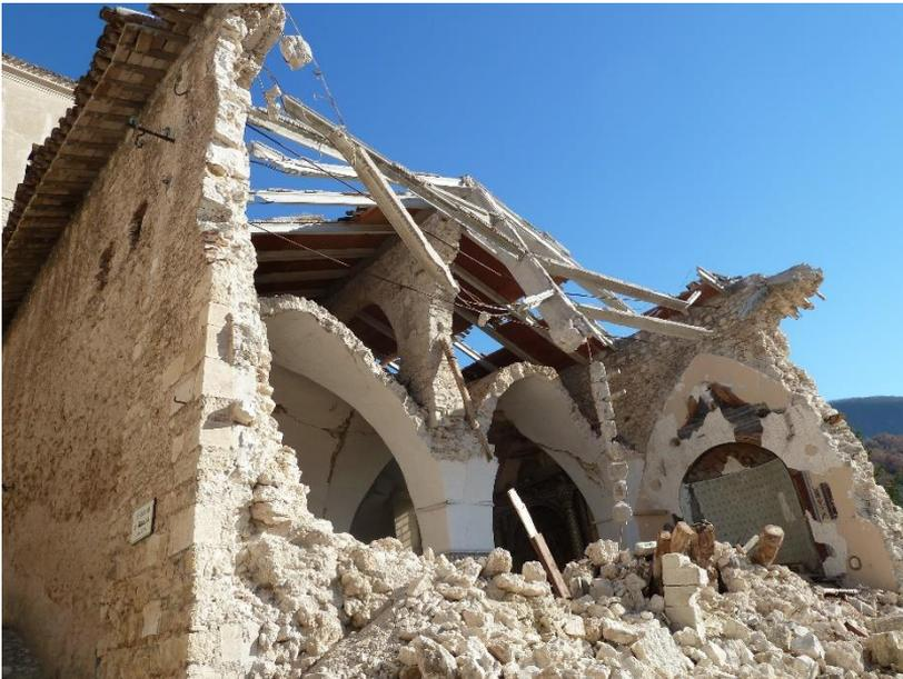
Fig. 85 - Collasso della copertura che era stata sostituita (A. Giannantoni, 28/10/2016)
