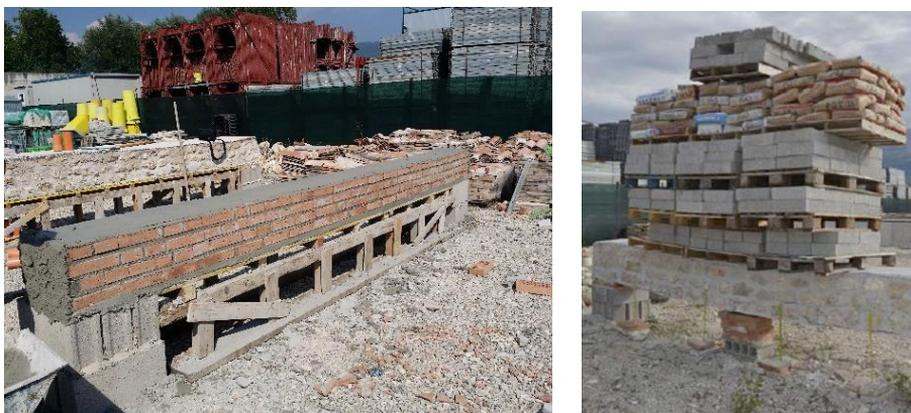
Fig. 258 - Costruzione del cordolo in muratura armata e prova di carico (A. Giannantoni 2016)
