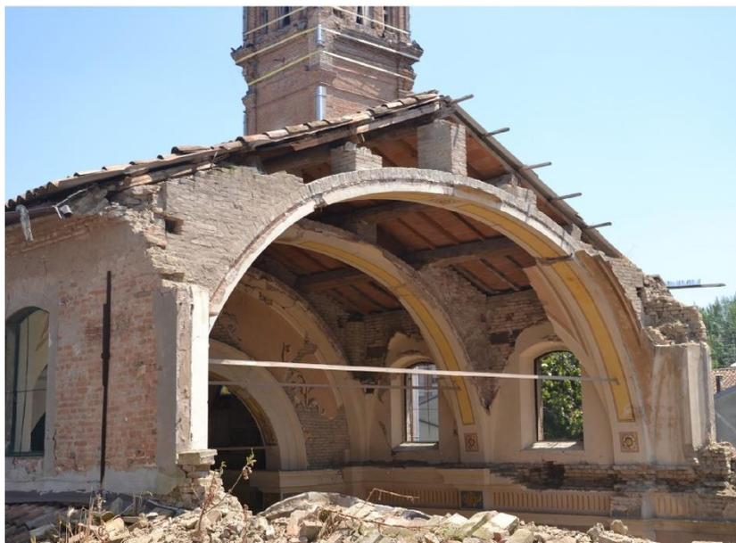
Fig. 70 - San Paolo a Concordia sulla Secchia (MO), cerniere plastiche nell'intradosso e nell'estradosso dell'arco (A. Giannantoni 2013)
