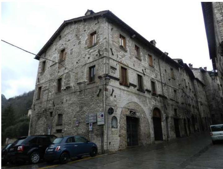
Fig. 8. Misure minime come l'inserimento di catene per incrementare la resistenza sismica di un edificio mantenendo il comportamento statico e dinamico della struttura storica (foto D. Concas).
