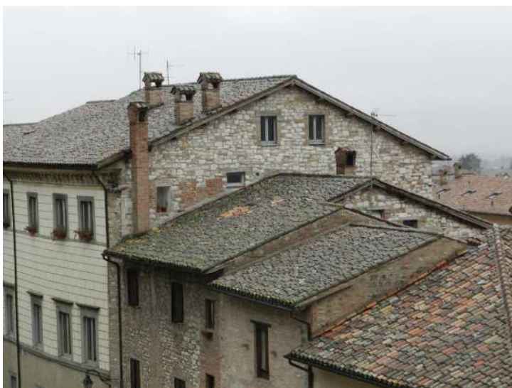
Fig. 9. Ricorso a materiali e tecniche tradizionali per conservare l'identità formale e costruttiva dei sistemi di copertura degli edifici storici (foto D. Concas).
