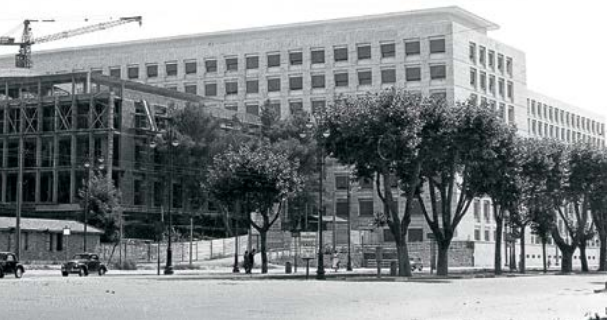
Nella pagina a fianco: una veduta dall'alto del cantiere durante la costruzione dell'edificio A. A sinistra, in alto: il complesso della FAO durante l'edificazione dell'Edificio A.
