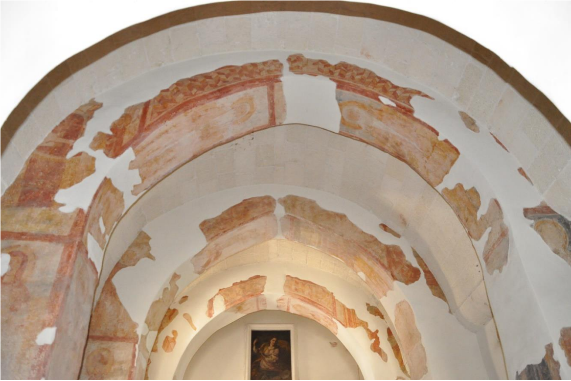
Fig.V.2.2.16. Muro Leccese, S. Marina, veduta generale del registro superiore dall'ingresso verso l'abside.
