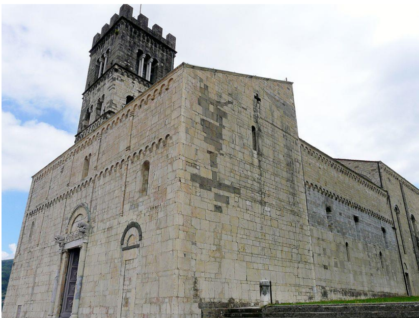
Fig. V.3.5.3. Barga S. Cristoforo, veduta della facciata e del lato sud.
