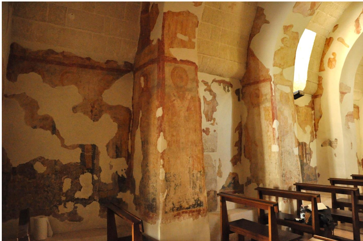
Fig. V.2.2.12. Muro Leccese, S. Marina, interno, veduta della parete sinistra.
