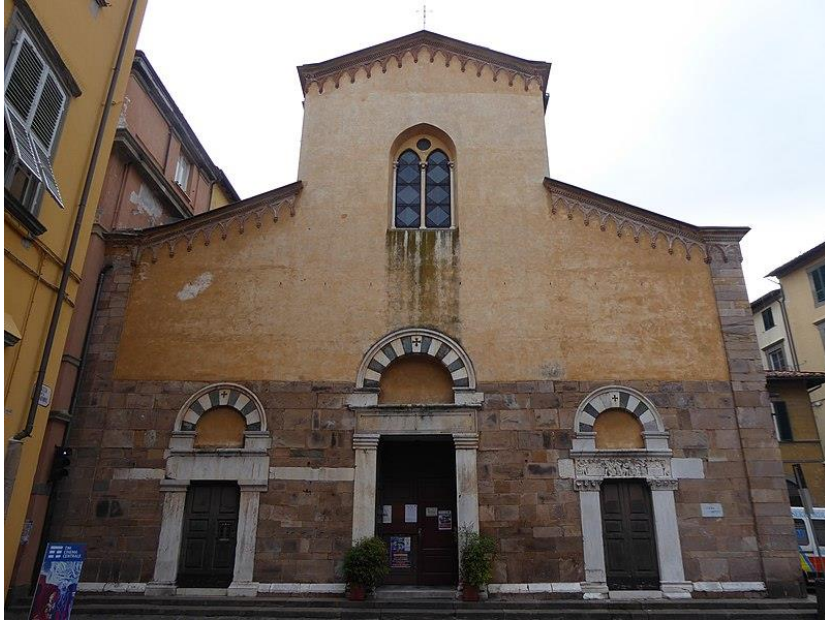
Fig. V.3.4.1. Lucca, S. Salvatore, facciata.
