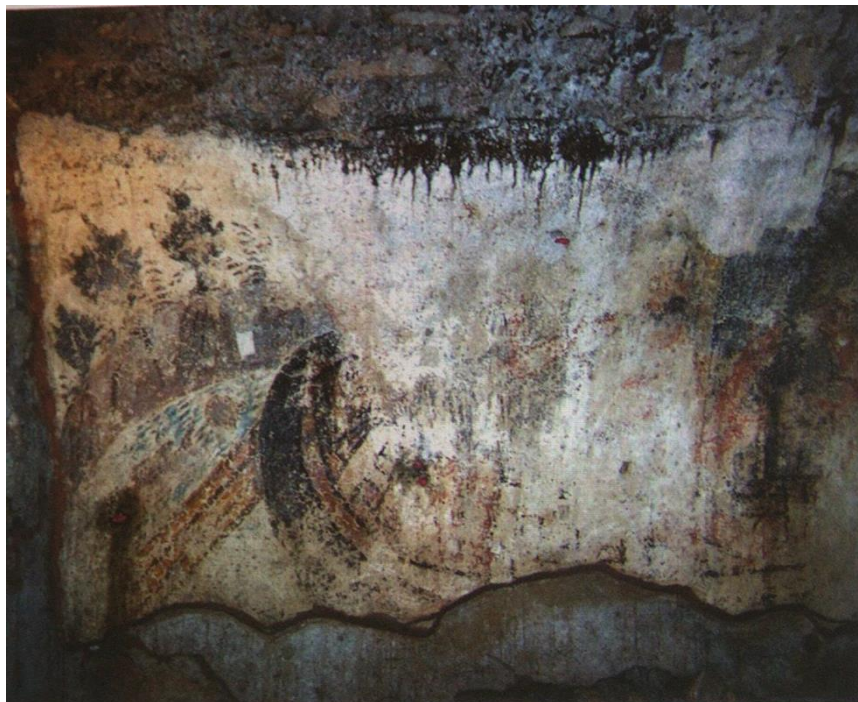
Fig. IV.2.A.8. Saranda, SS. Quaranta Martiri, cripta, seconda cappella sul lato orientale del corridoio, terzo episodio.
