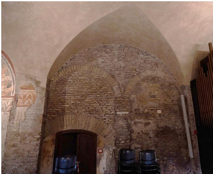
Fig. V.4.12.4. Roma, S. Saba, "quarta navata", terza campata, tamponatura degli archetti verso l'esterno. Fig. V.4.12.5. Roma, S. Saba, "quarta navata", archetto tamponato verso la navata centrale in corrispondenza dell'ultima campata.
