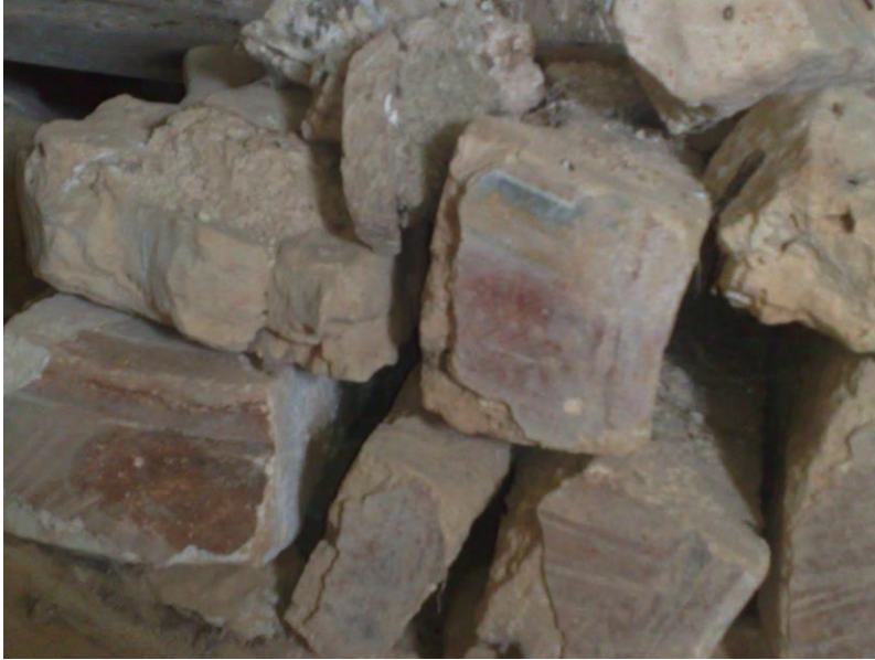
Fig. IV.2.1.5. Zante, Lagopodos, S. Nicola, materiale di risulta di un crollo con intonaci dipinti.
