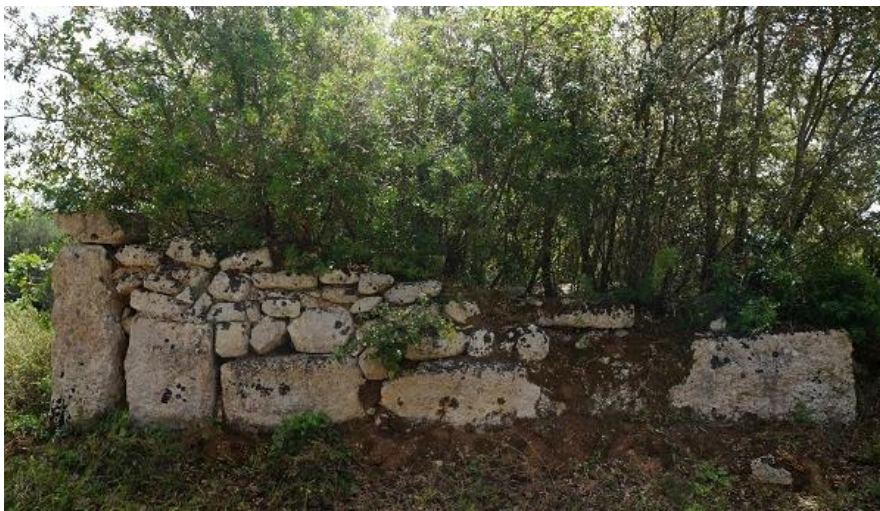
V.2.2.3. Muro Leccese (pressi), S. Barbara, resti della muratura del parato esterno.
