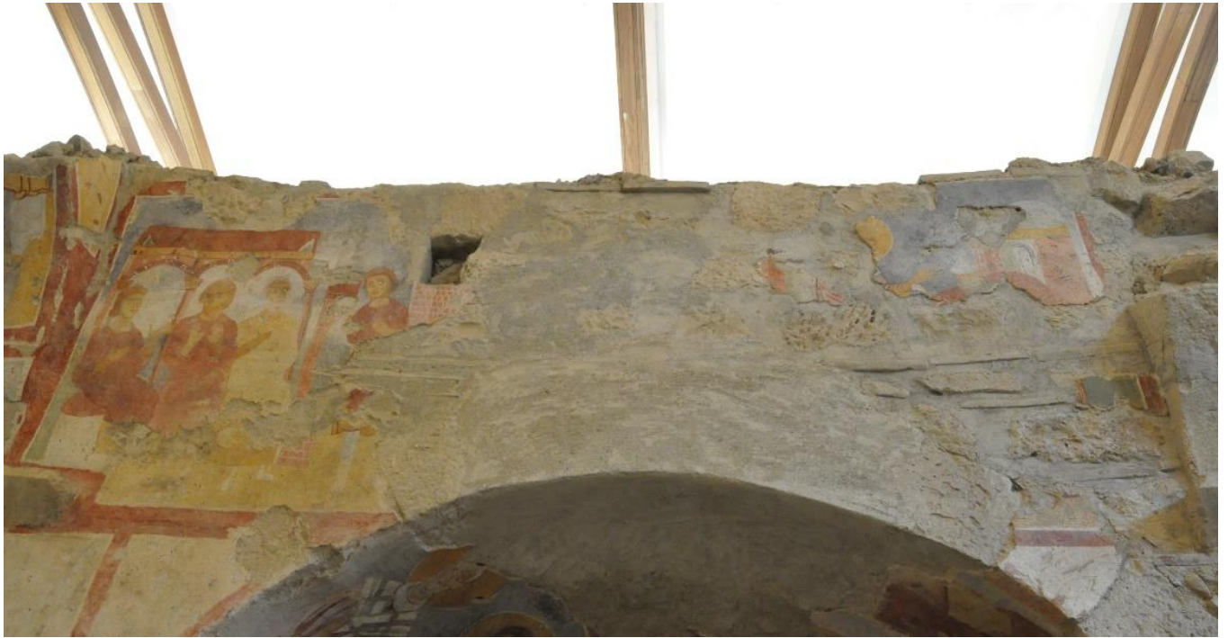
Fig.III.4.64. Demre, Aziz Nikolaos Kilisesi, "Camera funeraria sud", lato sud, seconda arcata.
