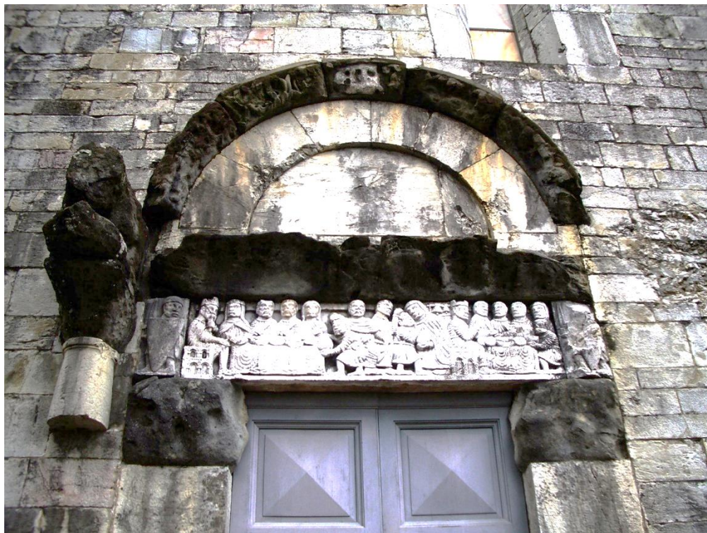
Fig.V.3.5.9. Barga, S. Cristoforo, lato nord, portale.
