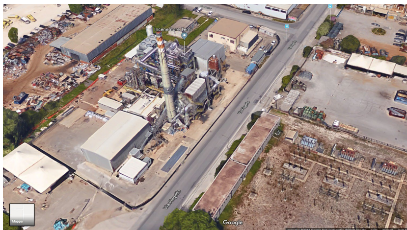
Fig. 13: Vista aerea dell'impianto terni EN.A
