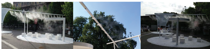
Figura 19. Progetto #nevicata14, Piazza Castello, Milano 2015. L'impianto di nebulizzazione è stato realizzato su binari fissi dotati di 30 ugelli nebulizzatori con diametro di 20 micron (dimensione che
