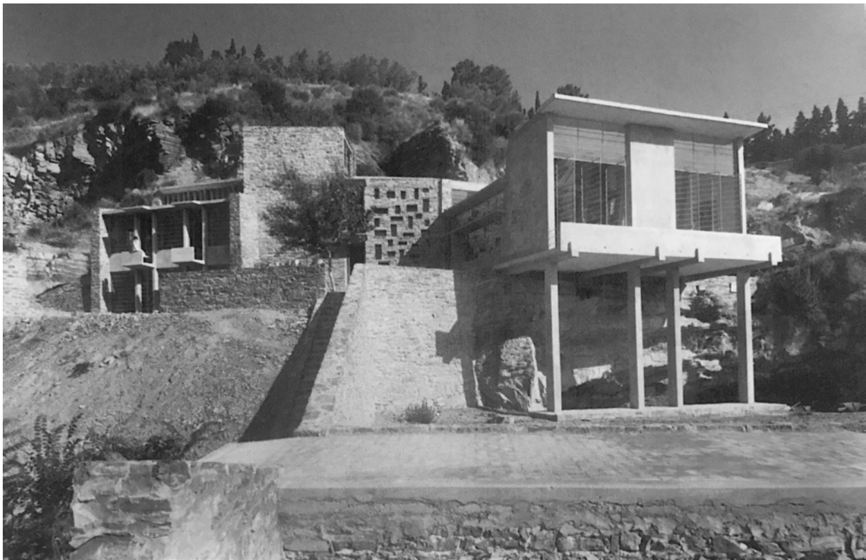
35. Casa-studio Ricci a Monterinaldi, Firenze, facciata principale realizzata secondo il primo progetto elaborato nel 1949, prima della sua trasformazione nel 1955 (foto Gianfranco Petrelli, casa-studio Ricci, Monterinaldi).
