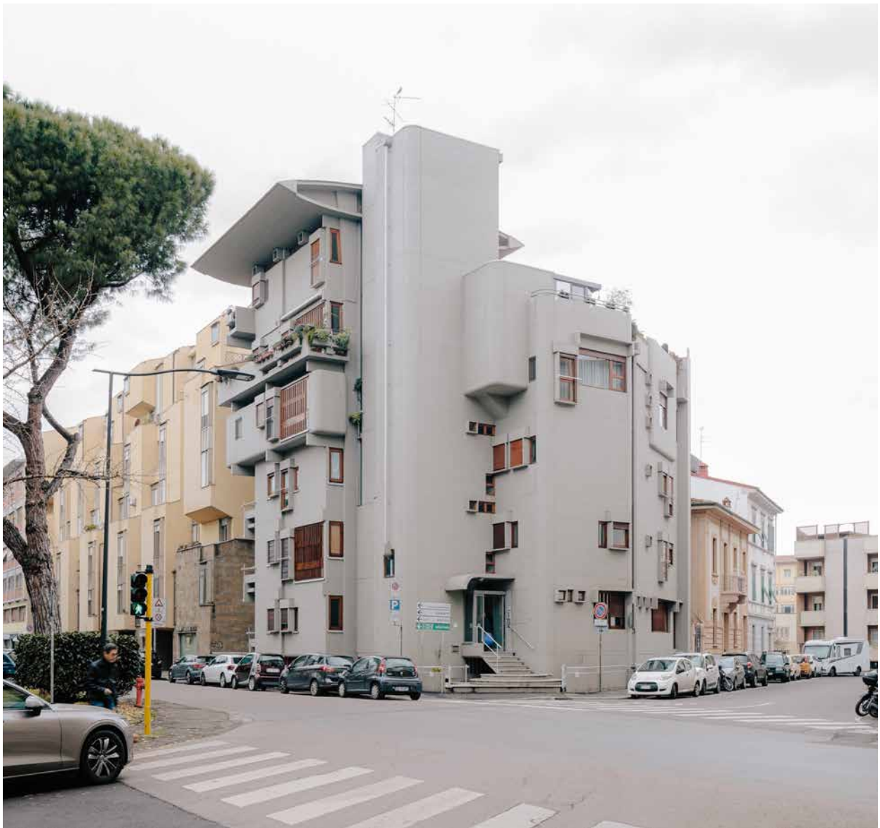
10. Leonardo Savioli, edificio per appartamenti in via Piagentina, Firenze (foto: Niccolò Vonci).
