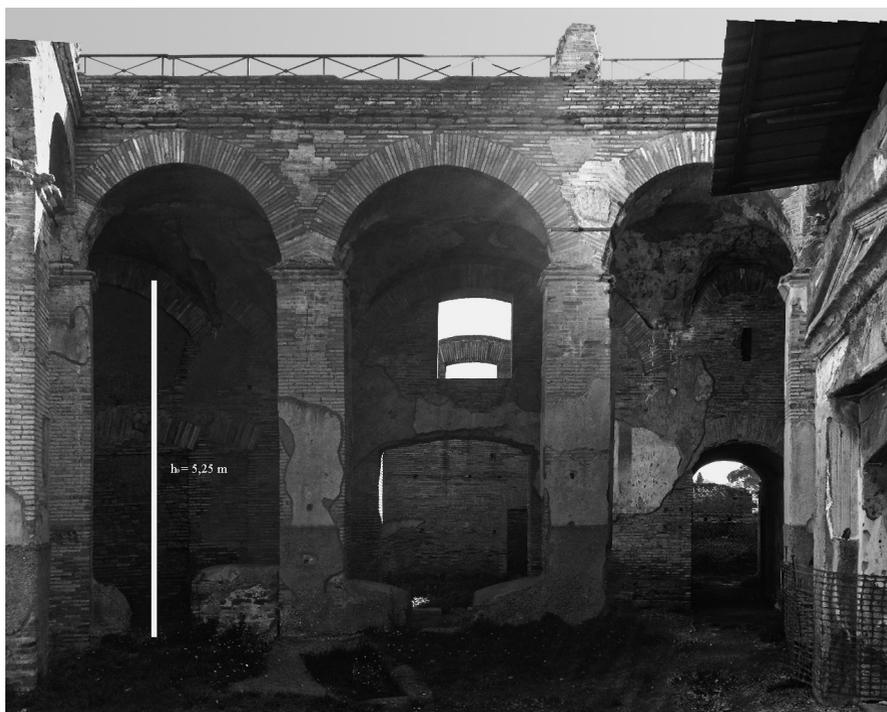
Fig. 6. Ostia, cortile del Caseggiato del Serapide, facciata interna. Nel fotoraddrizzamento eseguito dall'autore è stata evidenziata in bianco l'altezza ho dei pilastri (foto: Bigi).
