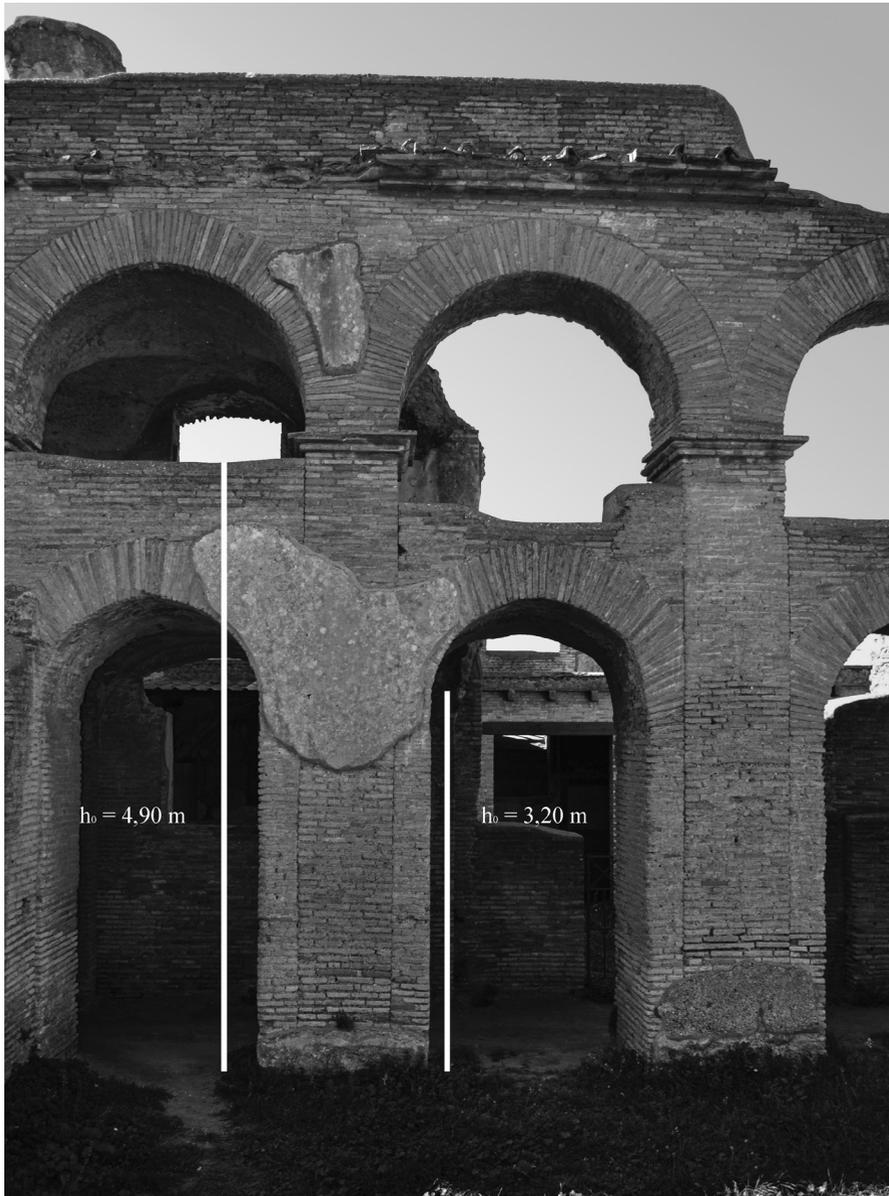
Fig. 5. Ostia, cortile del Caseggiato degli Aurighi, campata. In bianco sono state evidenziate le due altezze  $h_0$  dei pilastri prima e dopo l'intervento di «consolidamento» antico (foto: Bigi).
