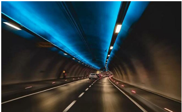
Figura 9 - Applicazione del cemento fotoluminescente in una galleria del tratto autostradale presso Civitanova Marche. Fonte: Federbeton
