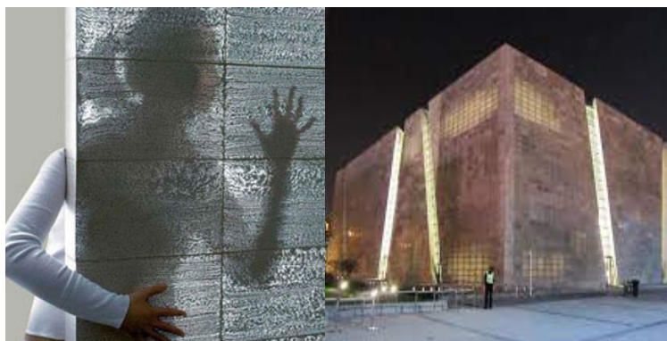
Figura 7 - Applicazione del cemento traslucido al Padiglione Italia di Expo Shanghai 2010.
