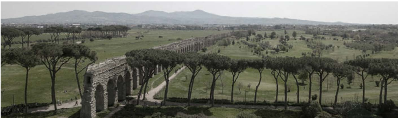
28/ La campagna romana con le infrastrutture lineari dell'acquedotto e della linea ferrata sul pianoro che proviene dai Colli Albani.
