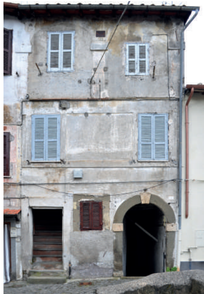
Fig. 3. Foto della facciata in via del Senile (2021).
