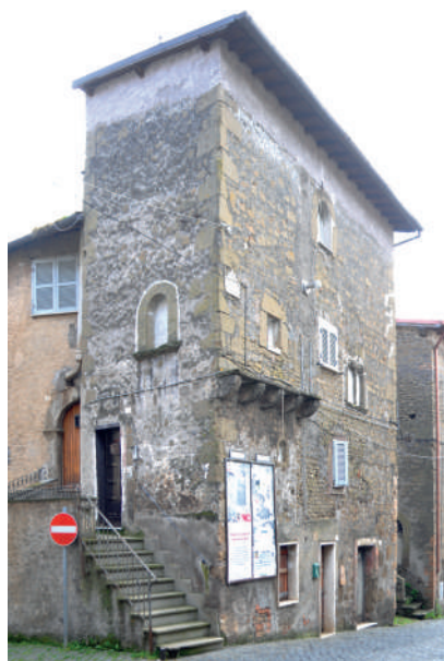
Fig. 2. Foto della facciata in via del Borgo (2021).
