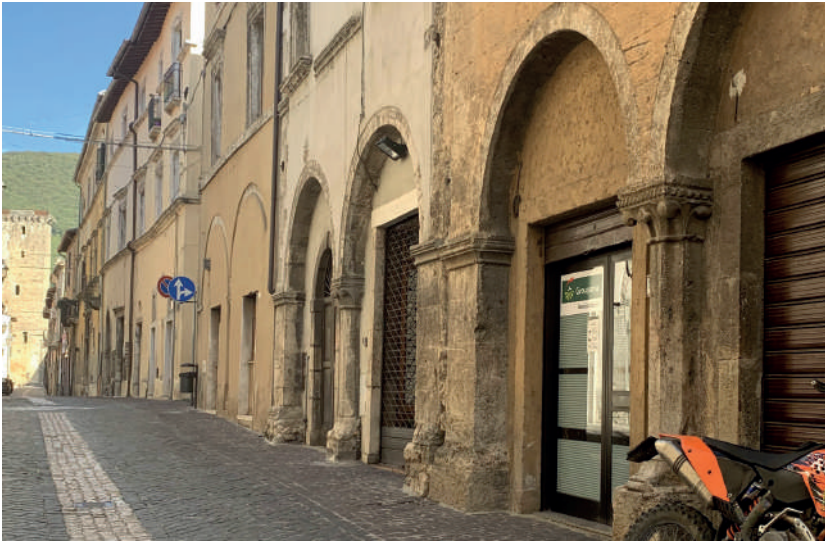
Fig. 4. Fronti urbani sul versante nord-est di corso Mazzini. Si rileggono chiaramente, al piano terra, le arcate su colonne e pilastri degli antichi portici attualmente tamponati (2021).
