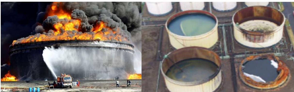
Figura 2.4: Incendio e affondamento del tetto galleggiante
