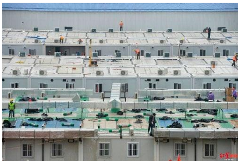
Figura 4: Foto di cantiere durante l'installazione dei moduli prefabbricati (fonte http://news.ifeng.com/ )
