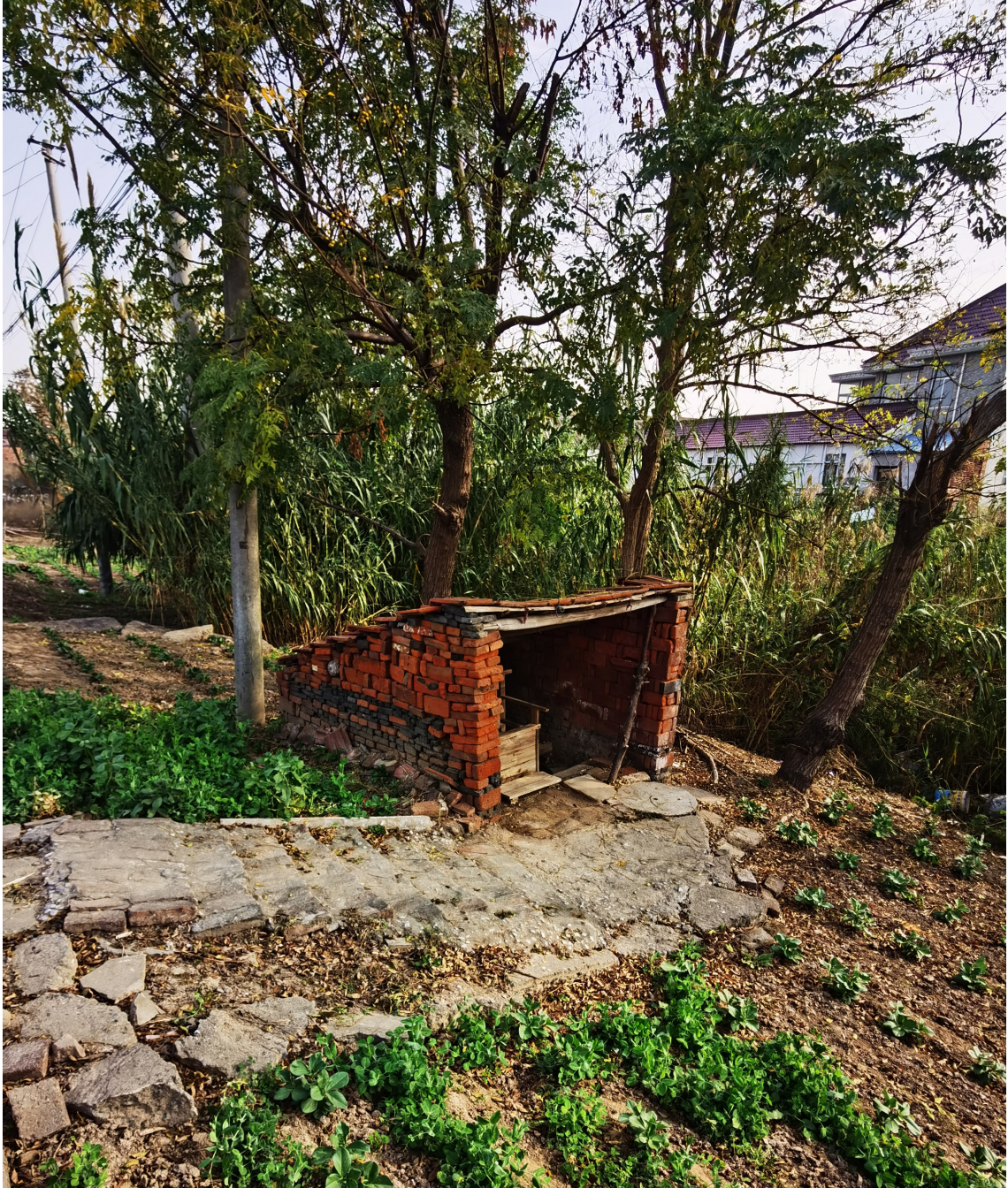
Figura 55: Servizi igienici in giardino, 2020, Nantong, Cina
