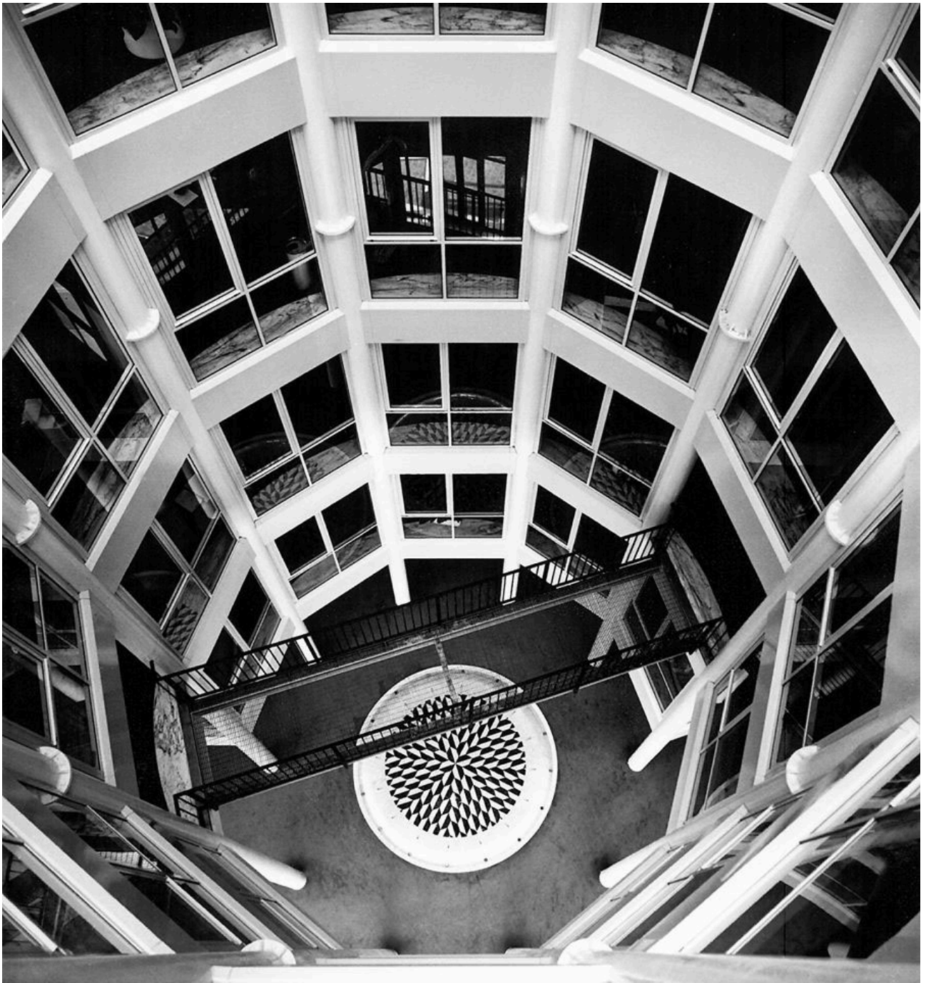
Fig. 6 - Il pozzo centrale della torre direzionale
