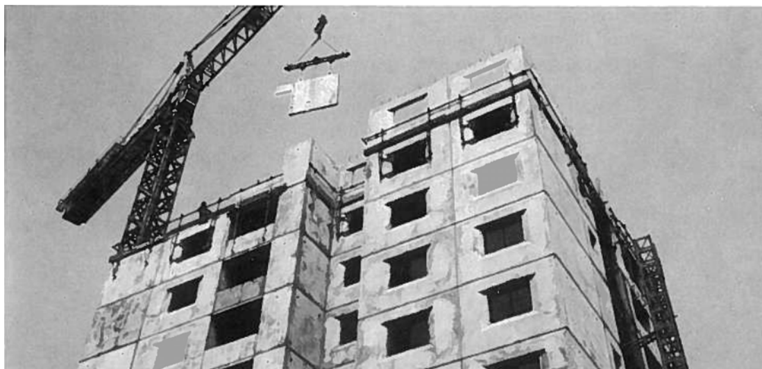
Fig.21: Vista della Costruzione. Fonte: Piroddi, E. (1984), "Operazione Tor Bella Monaca. Housing Development in Rome", L'Industria delle Costruzioni , n. 155, pp. 2-33
