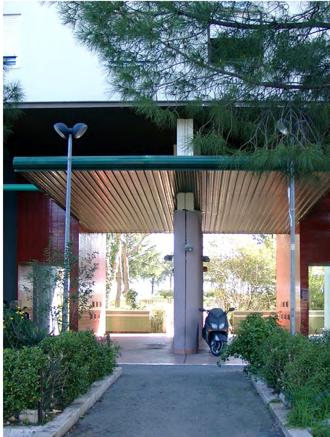
Fig.23: Vista di uno degli ingressi alla corte centrale del comparto R5. Foto di Laura Calcagnini
