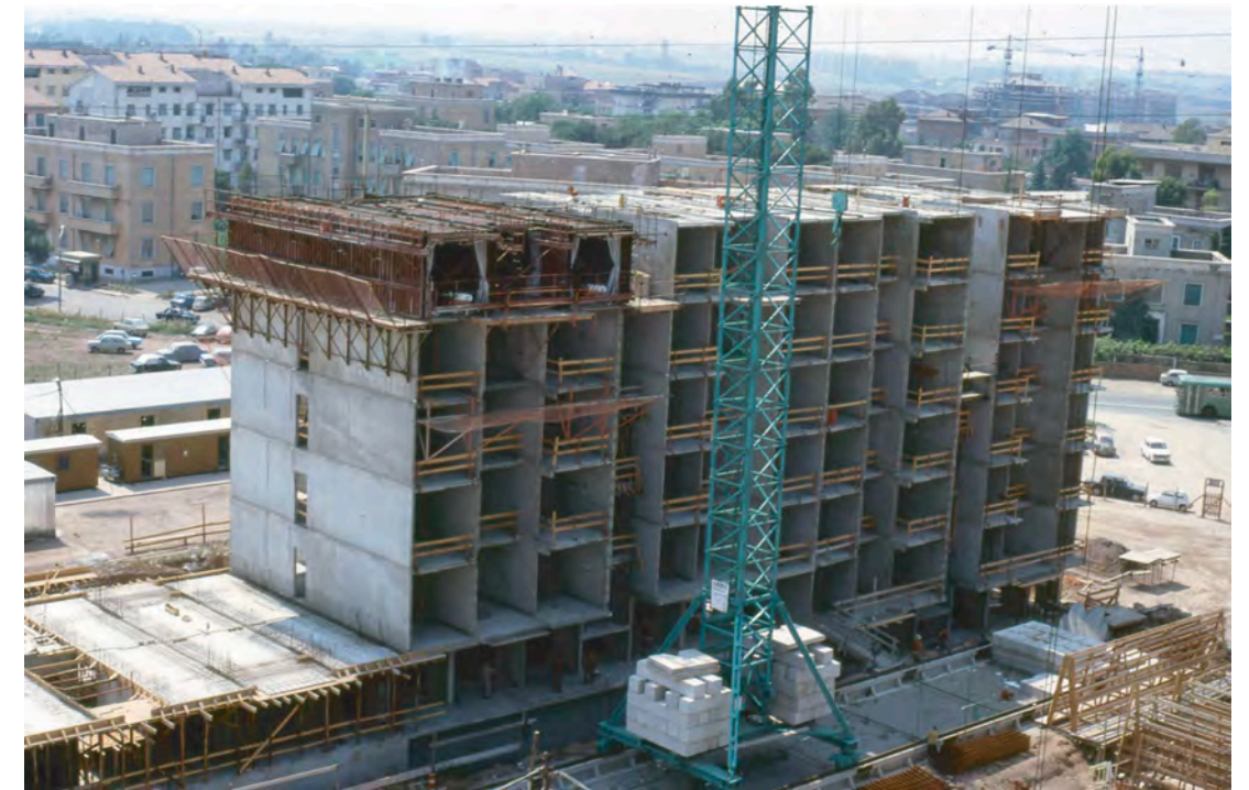
Fig.9: Laurentino, Roma: Edilizia industrializzata con casseforme tunnel e componenti secondari prefabbricati. Successione delle fasi; il prodotto di quindici giornate di lavoro. Fondo Pietro Barucci
