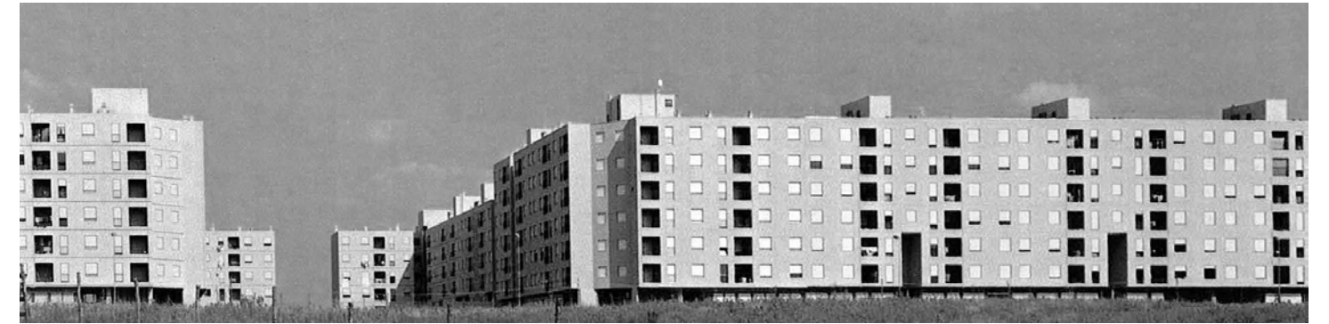
Fig.1: Il comparto R5 a Tor Bella Monaca al termine della costruzione negli anni '80. Fonte: Fondo Barucci
