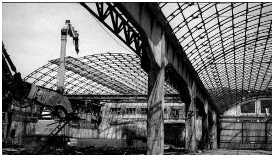
Figura 3. Foto durante la fase di smontaggio e demolizione delle coperture
