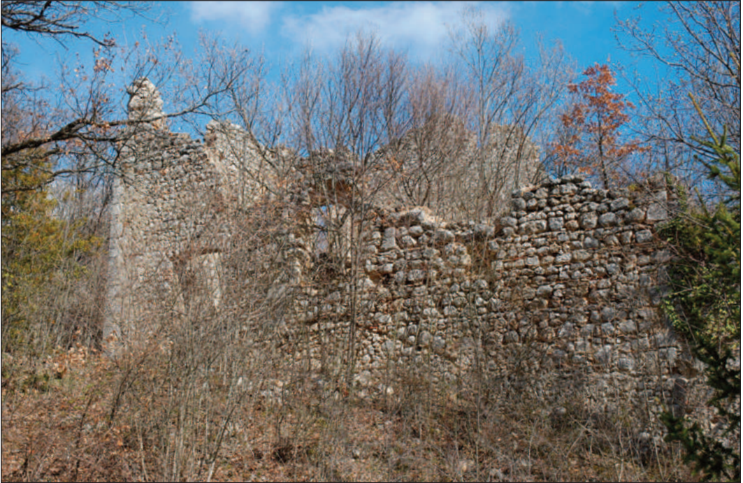
Figura 9. Resti del convento e delle sue sostruzioni visti da ovest (foto Più Studi Architettura, 2008)
