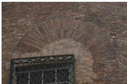
**Fig. 3.** Finestre con arco a doppia ghiera nell'abside della chiesa dei Santi V Nereo e Achilleo (795-818).
