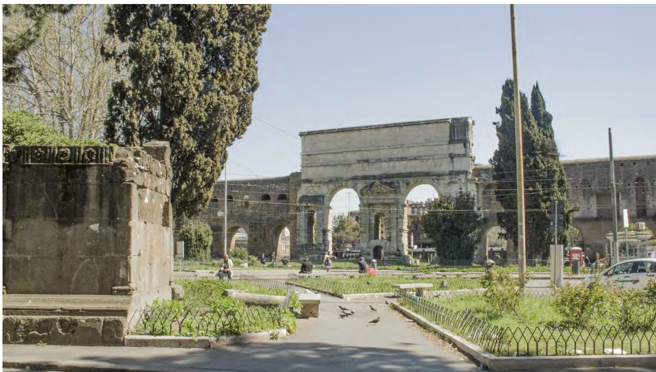
1: Veduta della piazza di Porta Maggiore. A sinistra il Sepolcro di Età Repubblicana, in fondo la Mostra dell'Acqua Claudia [foto di L. Anzini].
