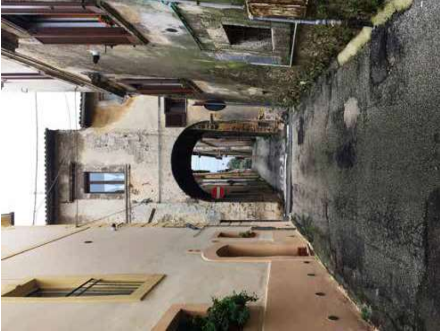
2. Cittaducale (Rieti), collegamento edilizio tra Unità Urbane attigue su via Duca Roberto. Si evidenziano inoltre alcuni degli elementi che contribuiscono alla definizione degli indici di trasformazioni e modifiche moderne e di vulnerabilità (sostituzione moderna delle finiture e degli infissi, degrado superficiale).
