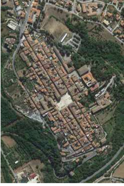
1. Il centro storico di Cittaducale (Rieti): dalla foto aerea è chiaramente leggibile la configurazione regolare dell'impianto. La griglia ortogonale del sistema viario definisce il perimetro delle Unità Urbane analizzate.
