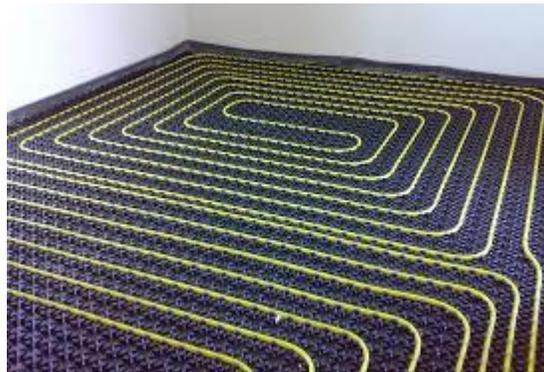
*Figura 23. Esempio di un pannello radiante a pavimento*
