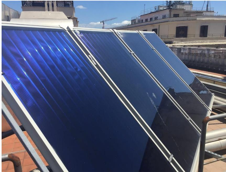
*Figura 67. Impianto solare termico per la produzione di ACS*
