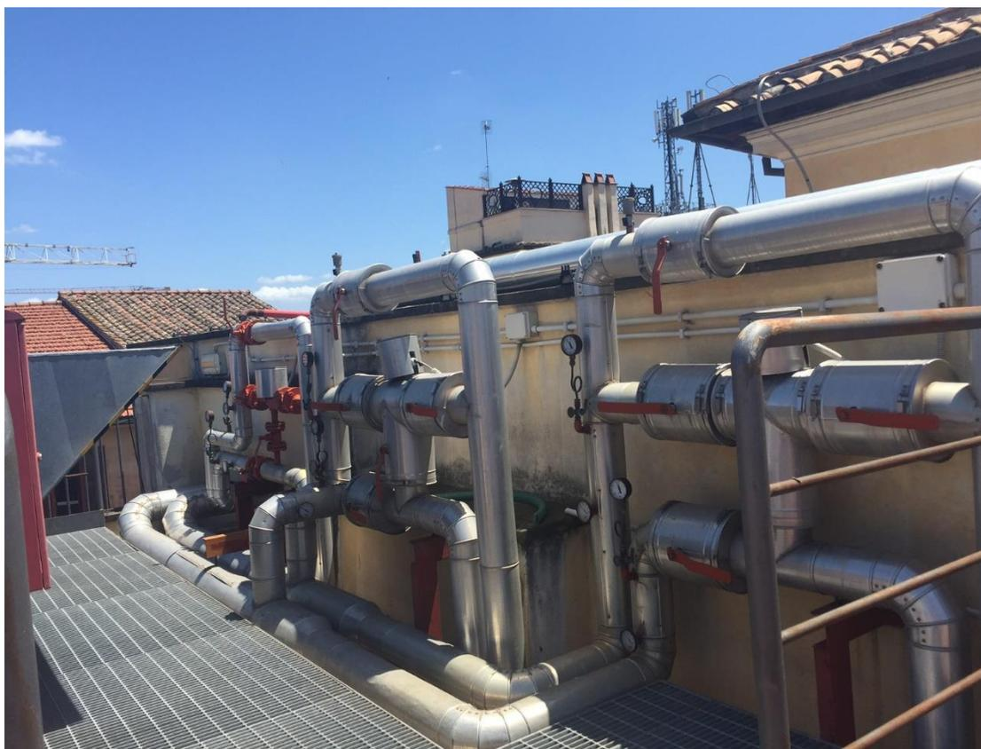
*Figura 64. Pompe e valvole di regolazione della centrale frigorifera*
