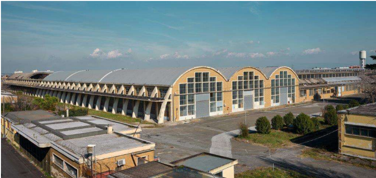
Fig. 3: The major sheds of ex-8thCe.ri.mant from the roof of the Museo dell'Altro e dell'Altrove (photo by Alexis)
