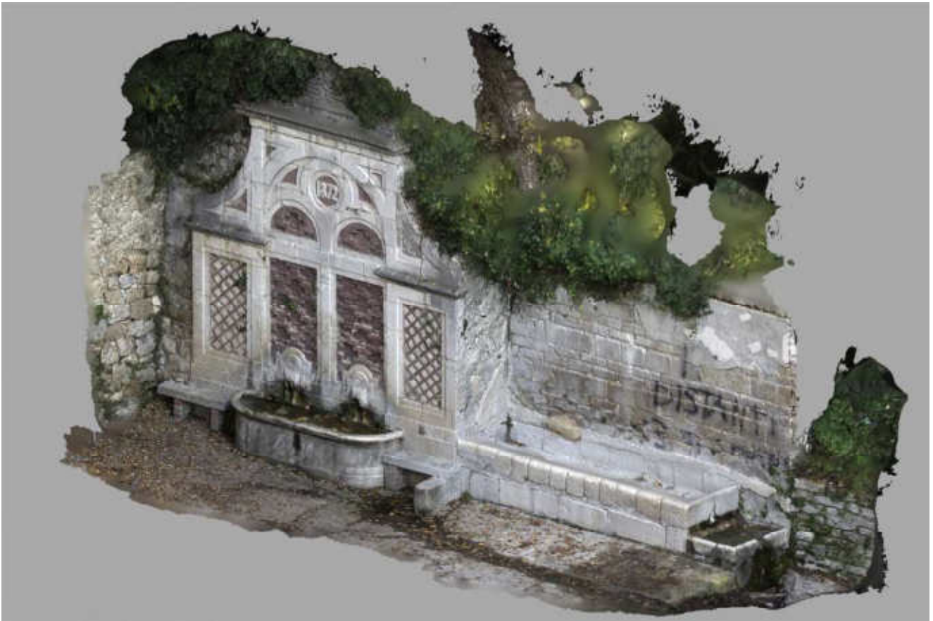
9.12 S.Giorgio la Molara, la Fontana Nuova, rilievo fotogrammetrico, vista assonometrica (rilievo ed elaborazione M. Carpiceci)
