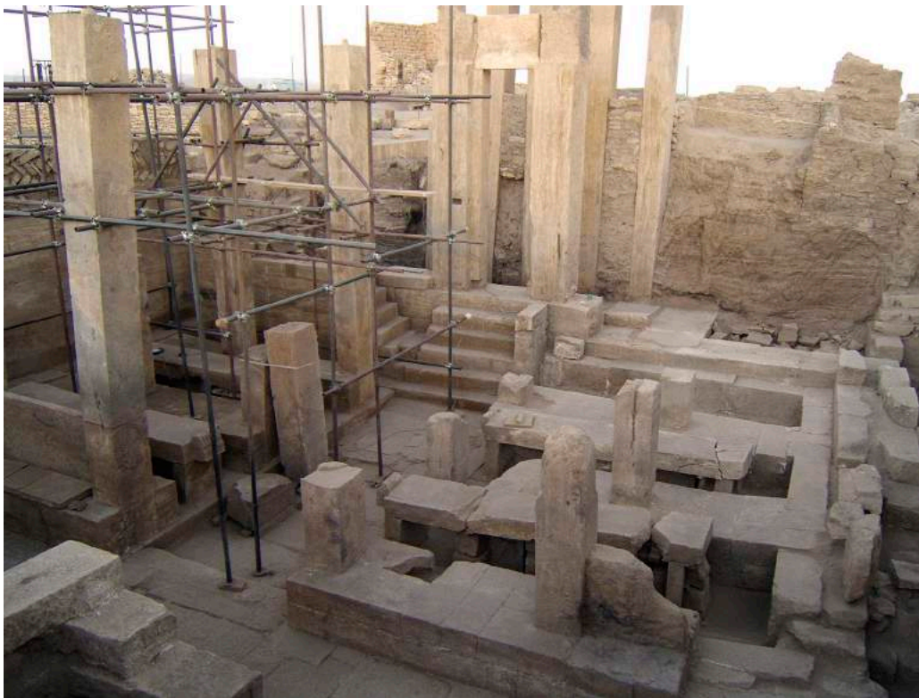
Fig. 9. La sala ipostila dopo le operazioni di scavo, da est. (A. de Maigret 2005 ©MAIRY)
