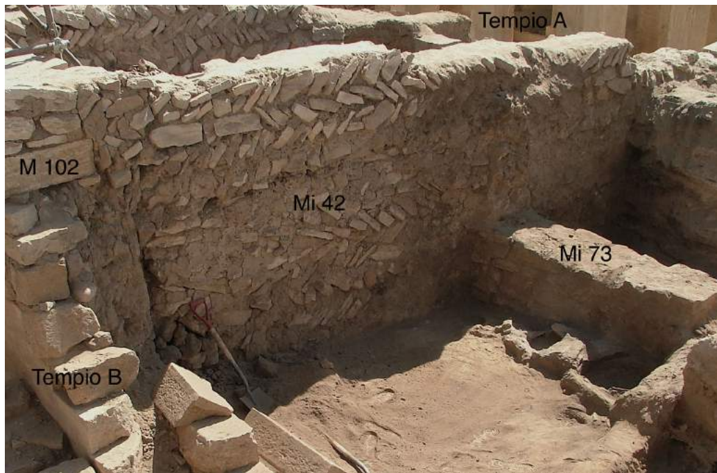
Fig. 42. Parte delle strutture islamiche realizzate nell'area tra il Tempio A e il Tempio B, da nord. (A. Agostini 2006 ©MAIRY)
