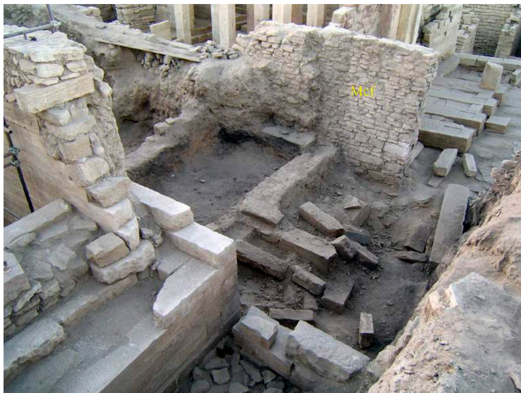
Fig. 43. Messa in luce del crollo di alcuni elementi pertinenti al propileo del Tempio A, al di sotto delle strutture islamiche più antiche, da nord. (A. de Maigret 2006 ©MAIRY)
