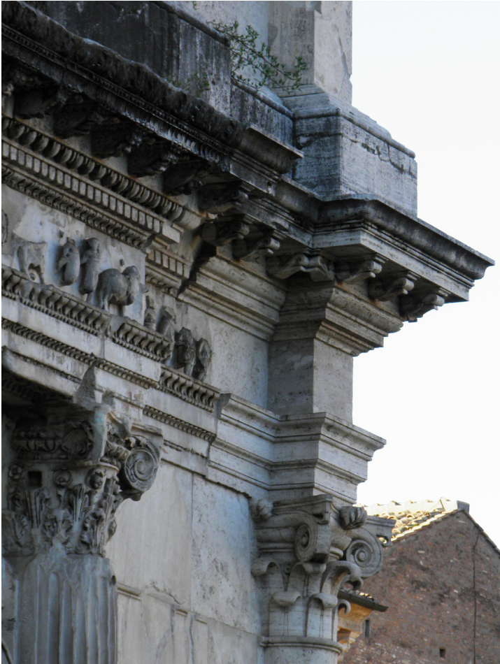
Fig. 1. Roma, Arco di Tito, lato orientale, particolare dell'ordine architettonico con parti originali e di ricostruzione.
