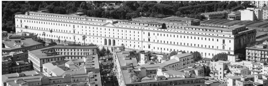
Palazzo Fuga, Real Albergo dei Poveri, Napoli (1746-1772)
