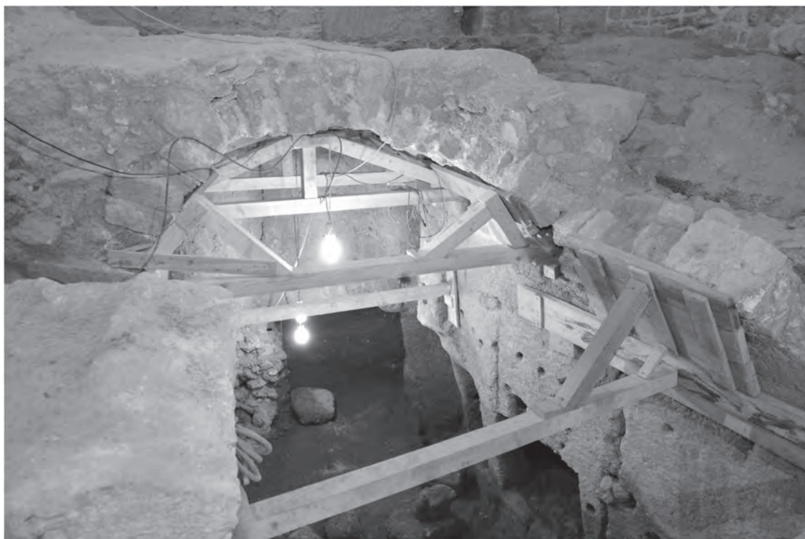
Fig. 5 - Castello Aragonese, Torrione di S. Cristoforo. Aula voltata vista da Sud-Est (foto di A. Vinella)
