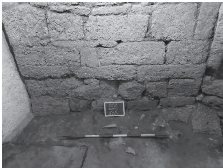
Fig. 15 - Castello Aragonese, Torrione di S. Cristoforo. Aula voltata, tecnica costruttiva della parete meridionale del vano (foto di F. Giletti)
