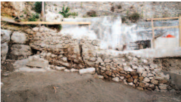
Fig. 109. Setto murario con funzione di parapetto
