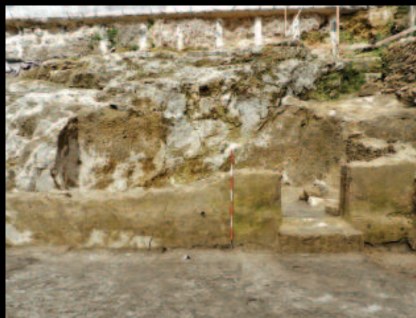
Fig. 115. Facciavista intonacata del setto murario, vista dall'ambiente Sud
