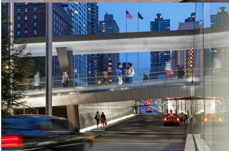
fig.39-40 accesso Columbus Ave. dopo l'intervento, credit: Diller Scofidio + Renfro [Inside Out, 2012]
