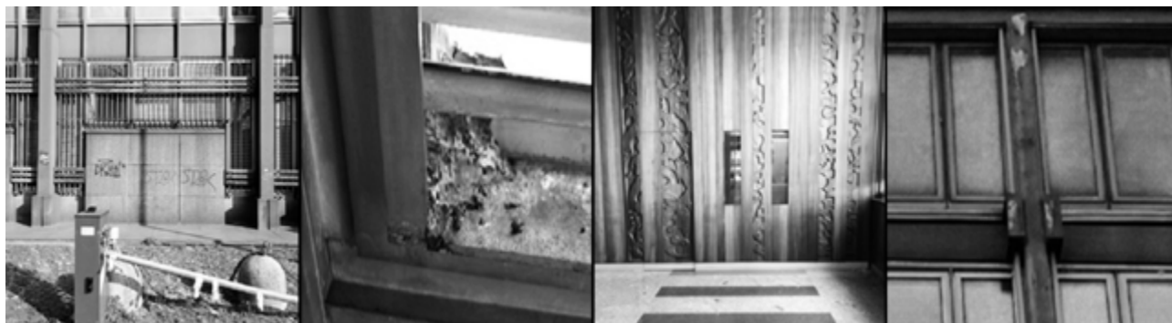
Fig. 4. Elementi di degrado di dettaglio dell'edificio: l'area esterna, un telaio in alluminio, la boiserie nel salone d'ingresso, il curtain-wall - © 2019, E. Chiffi.
