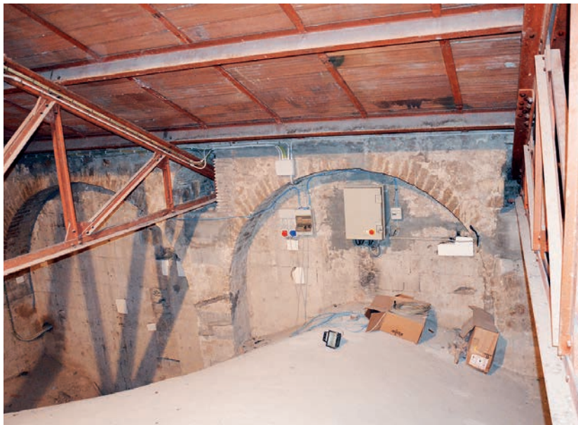
Fig. 5. Duomo di Orvieto, sottotetto. Gli archi di scarico delle capriate (in origine di legno, dal 1958-1959 d'acciaio) sopra il presbiterio, marzo 2012.
