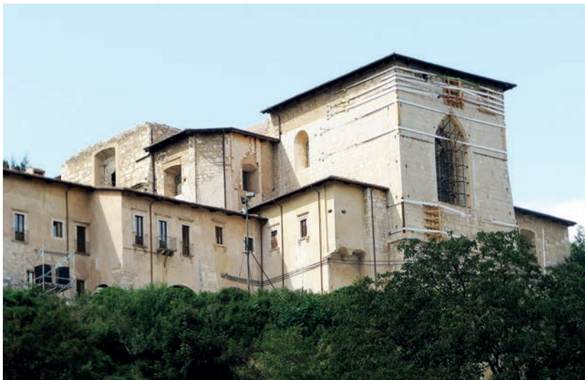
Fig. 18. L'Aquila, Santa Maria di Collemaggio. L'abside della basilica dopo il sisma del 6 aprile 2009, agosto 2009.
