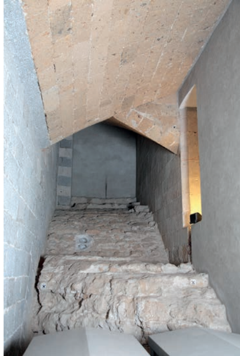
Fig. 7. Duomo di Orvieto, resti della struttura di sostegno della scala che dal presbiterio scendeva alla parte sinistra della cripta. Sul fondo è il muro più tardo di chiusura dell'accesso al livello della cripta.
