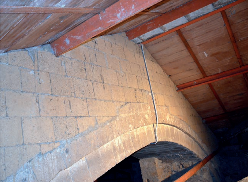
Fig. 3. Duomo di Orvieto, sottotetto. L'arco-diaframma tra presbiterio e crociera centrale del transetto, marzo 2012.
