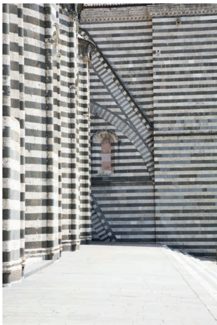
Fig. 13. Duomo di Orvieto, sistema di contraffortamento del fianco sud. Il rivestimento bicolore degli elementi strutturali propone, lungo la parete piena della cappella, lo schema di due puntoni inclinati e una struttura ad arco seguita da un massiccio muro di contrafforte (foto dell'A.).
