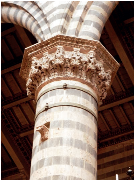
Fig. 14. Duomo di Orvieto. Uno dei fori quadrati con mensola modanata in pietra su uno dei piloni a sezione circolare, maggio 2016.
