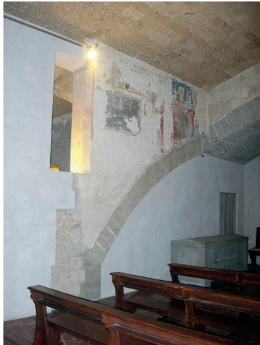
Fig. 16. Duomo di Orvieto, dettaglio della parete sinistra della cripta con tracce di altri affreschi, medievali e non. In alto, un'apertura di origine e funzione imprecisate, forse di una diversa struttura muraria.
