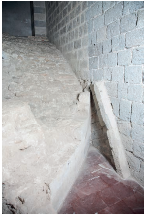
Fig. 8. Duomo di Orvieto, resti della struttura di sostegno della scala che scendeva dal presbiterio alla parte destra della cripta. Sul fondo dell'immagine è visibile il più tardo muro di chiusura dell'accesso al livello della cripta.
