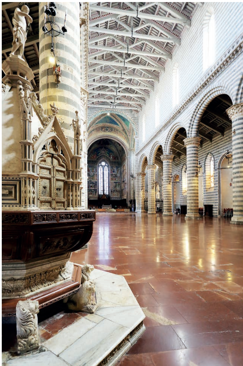
Fig. 21. Duomo di Orvieto, navata centrale. Negativo aspetto specchiante del pavimento sostitutivo di quello originario con l'intervento del 1954.
