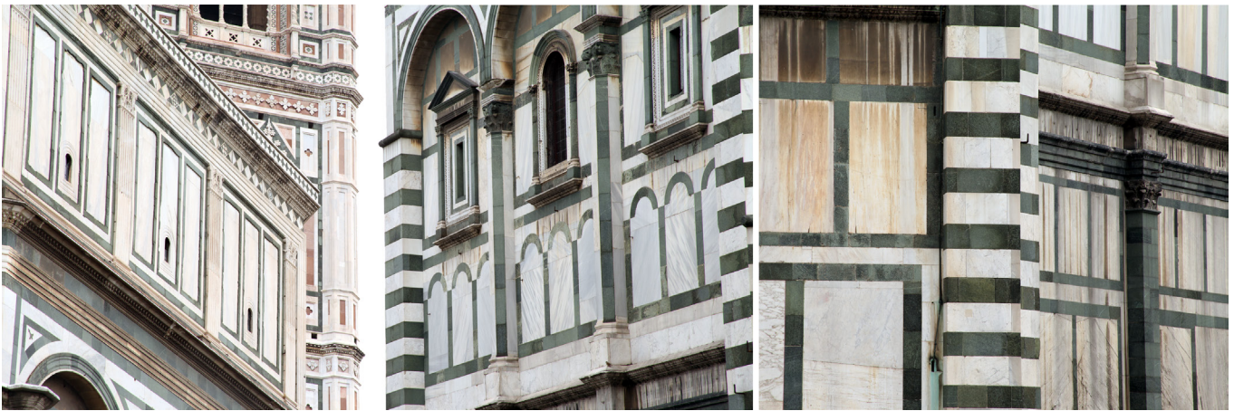
2.16/ Il rivestimento marmoreo del Battistero. Da sinistra: l'attico del lato sud ovest e sul fondo il campanile di Giotto; il secondo registro con le finestre a edicola del lato nord ovest; il pilastro angolare "zebrato" dell'angolo sud ovest. Foto scattate durante la campagna di rilevamento .
