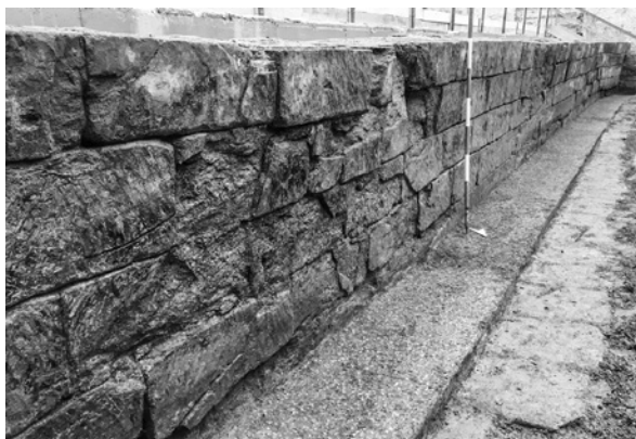
Fig. 7. Acquedotto. Paramento interno in blocchi di tufo della parete sud e piano di scorrimento in cocciopesto, vista da Nord-Est.
