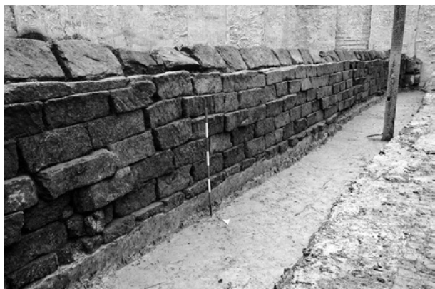
Fig. 4. Acquedotto. Paramento esterno in blocchi di tufo della parete nord, vista da Nord-Est.
