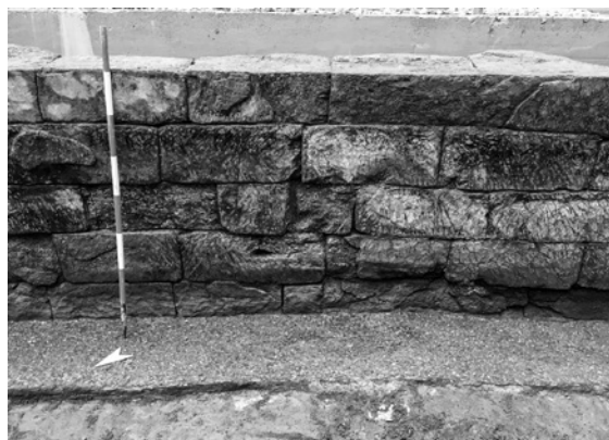
Fig. 5. Acquedotto. Paramento interno in blocchi di tufo della parete sud, vista da Nord.
