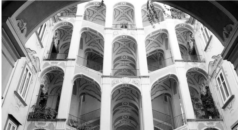
Fig. 2. Palazzo dello Spagnolo costruito nel 1738. Foto dell'autrice, 2019.
