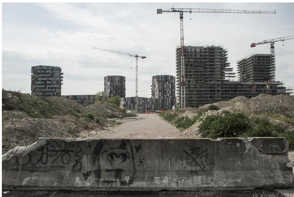
Fig. 8. Il cantiere di piazza Liber Paradisus.
