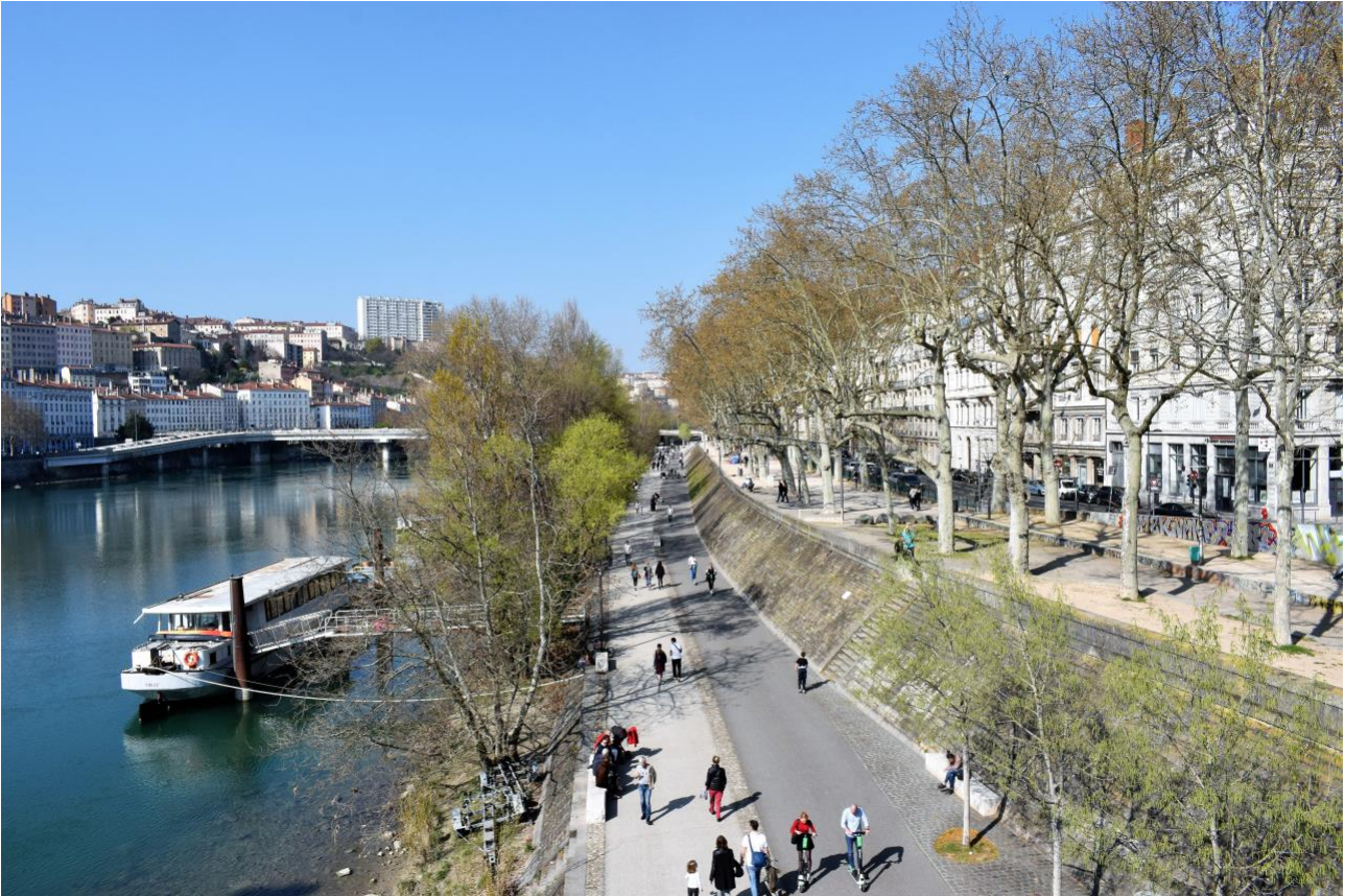
(Fig.2_3) Il lungo Rodano è stato costruito con alti muraglioni e banchine sottostanti che hanno relegato in basso il traffico fluviale e reso distante la fruizione immediata dell'acqua. Le nuove sistemazioni pedonali hanno restituito una fruibilità allargata e creato nuove connessioni tra il piano stradale e la superficie dell'acqua.
